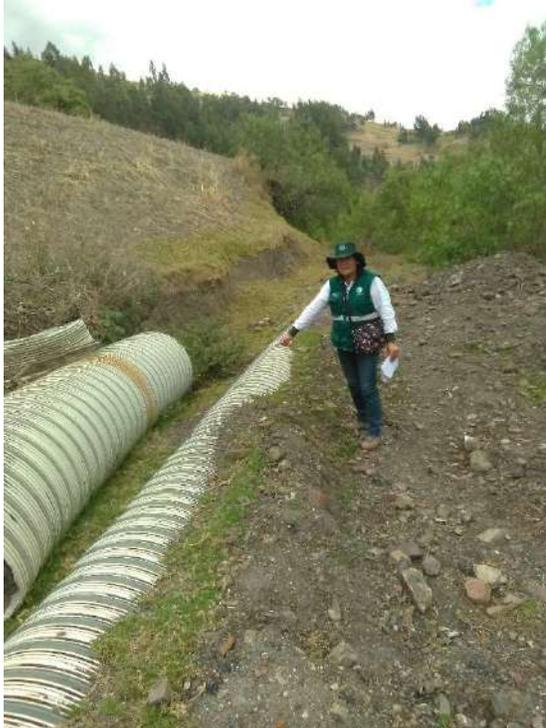
Canal con tubería perfilada de 800 mm, que se encuentra semi enterrada desde la progresiva 9+193 a 9+200
