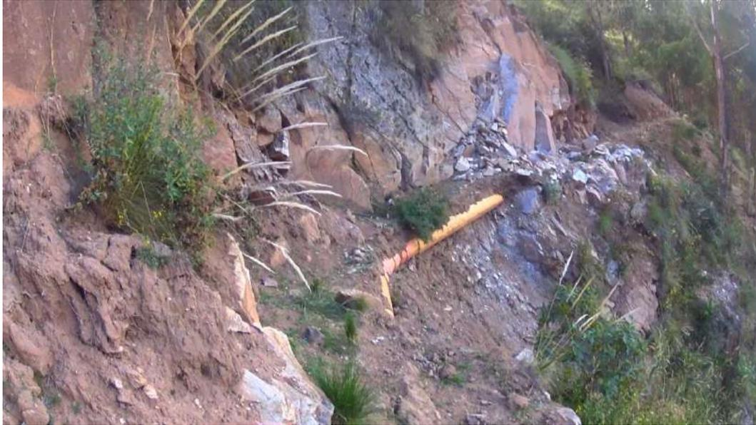
3. Tubería PVC, expuesta a los rayos solares, mal procedimiento constructivo.
