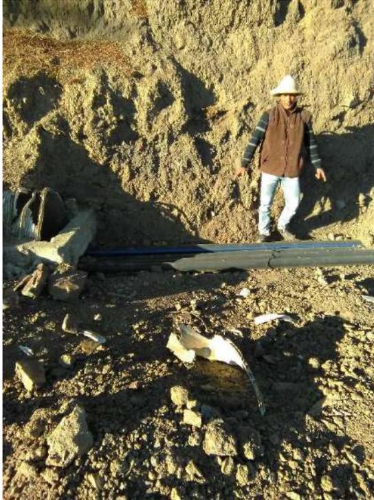
Zona de falla geológica, donde la tubería perfilada de 800 mm ha sufrido daño y fue desinstalada y reemplazada por los beneficiarios por 04 tuberías de HDPE Km 9+200 a 9+250
