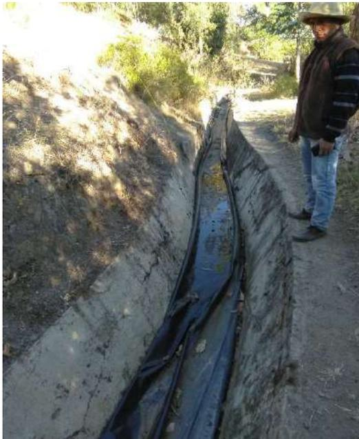
Canal antiguo sin intervención con el proyecto desde Km 7+860 a 7+975, con piso y muros fisurados, por lo que utilizan manga para conducir agua
