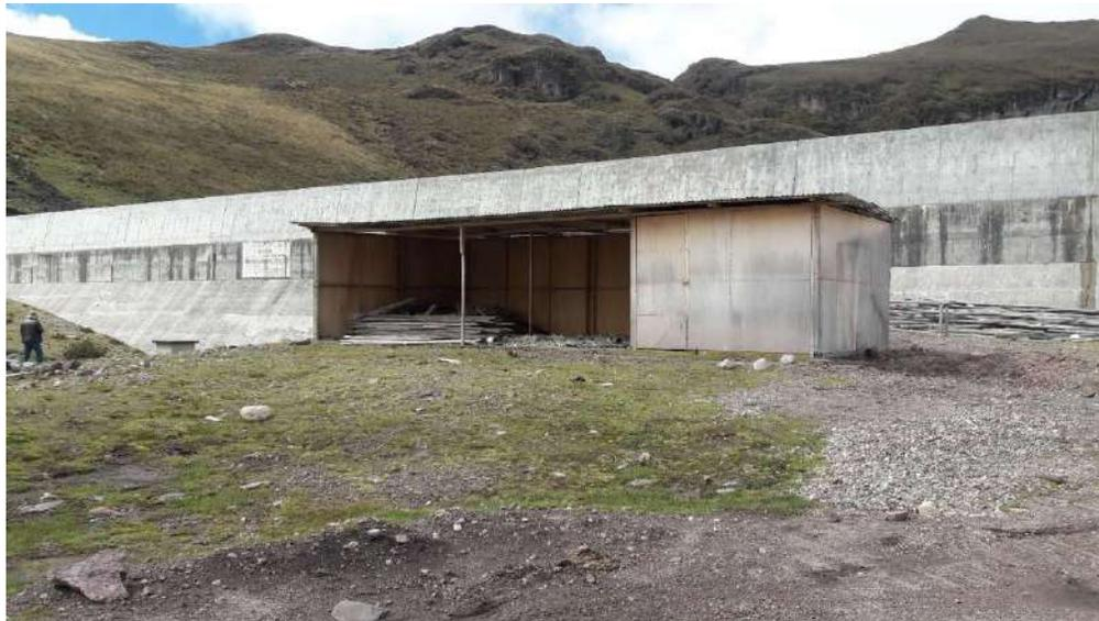
**Fig.N°15.-** En la imagen se observa la alteración del bazo natural de la presa, lo cual viene generando las filtraciones aguas debaio de la presa de Yuraccvacu.
