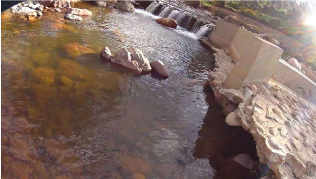
1. Captación socavada en la base, mal procedimiento constructivo.
