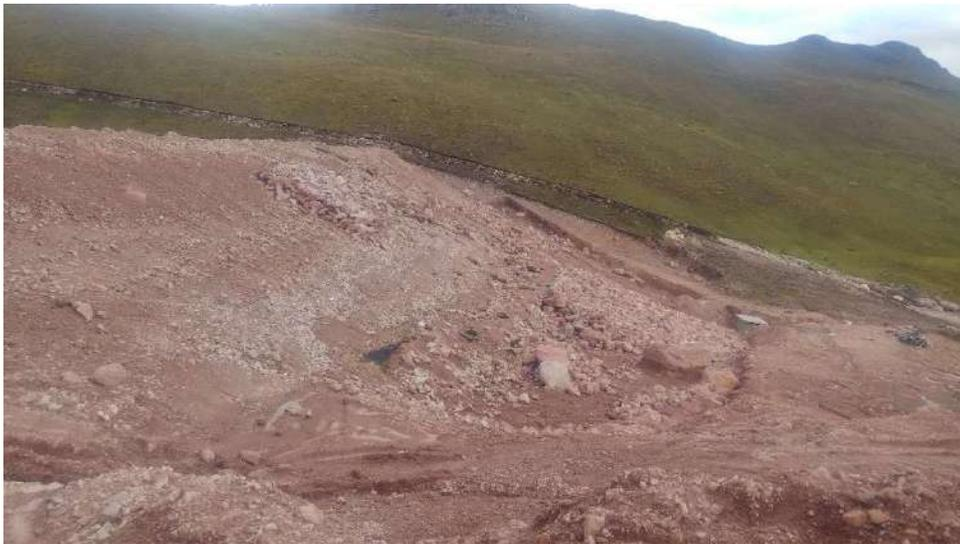
**Fig.N°04.-** La flecha señala la conformación del enrocado de la foto anterior. Se observa la falta de conformación del talud aguas abajo
