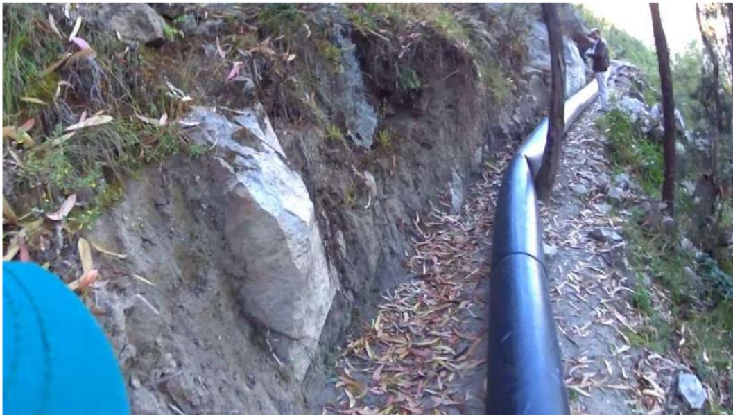
6. Tubería HDPE, tendida en plataforma de canal, doblada y fisurada por mal procedimiento constructivo o mala dirección técnica.
