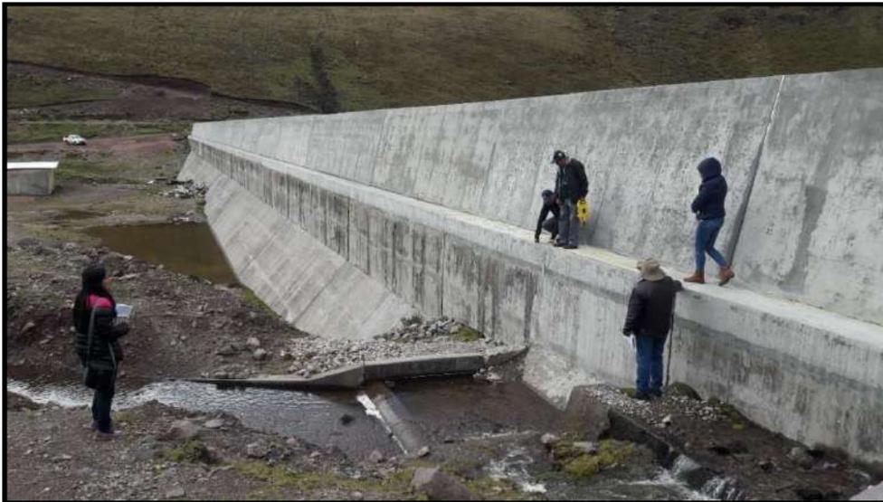
**Fig.N°11.-** La línea señala la zona del aliviadero relleno con concreto
