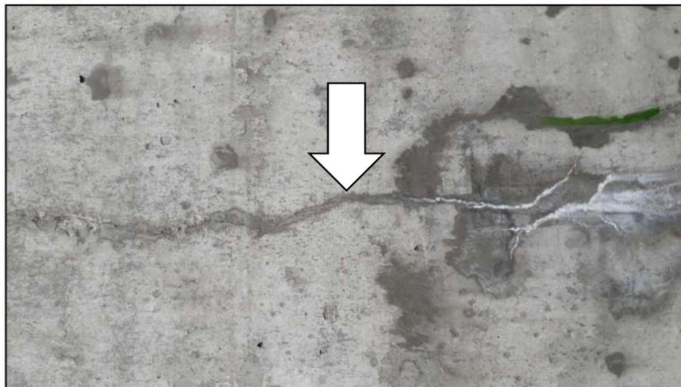
Fig.N°13.- Se observa las fisuras que se presenta en el muro de encimado
