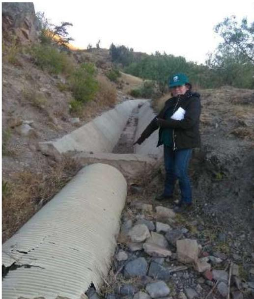
Canal de concreto de sección trapezoidal intervenida con el proyecto desde la progresiva 9+523 a 9+630, observándose la tubería instalada aguas abajo se encuentra completamente dañada por estar a la intemperie
