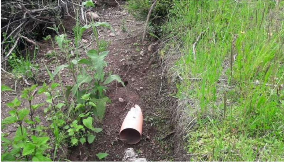
**Fig.N°10.-** Se observa Tubería D=6” Expuesta en la progresiva 0+260, 0+320, 0+760
