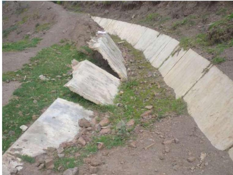
**PROGRESIVAS KM. 8+540 a 8+579: Asentamiento de talud izquierdo del canal, debido al agua proveniente de las lluvias, que ha filtrado por las juntas. No se ha colocado el relleno de juntas ni construido muros de contención.**
