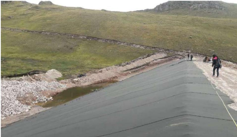
**Fig.N°01.-** Se observa el talud aguas arriba de la presa Yuraccyacu cubierto con geotextil
