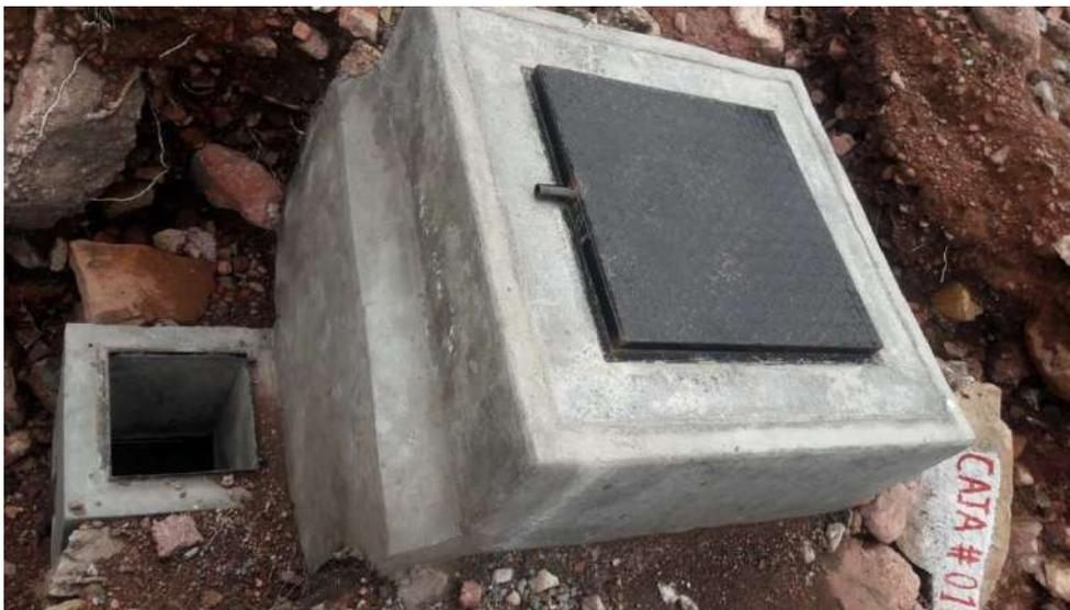
**Fig.N°09.-** Se observa la Caja de inspección
