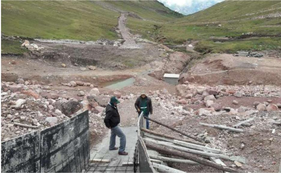
**Fig.N°02.-** Se observa, la salida del aliviadero y al fondo la caseta de válvulas Yuraccvacu cubierto con geotextil.
