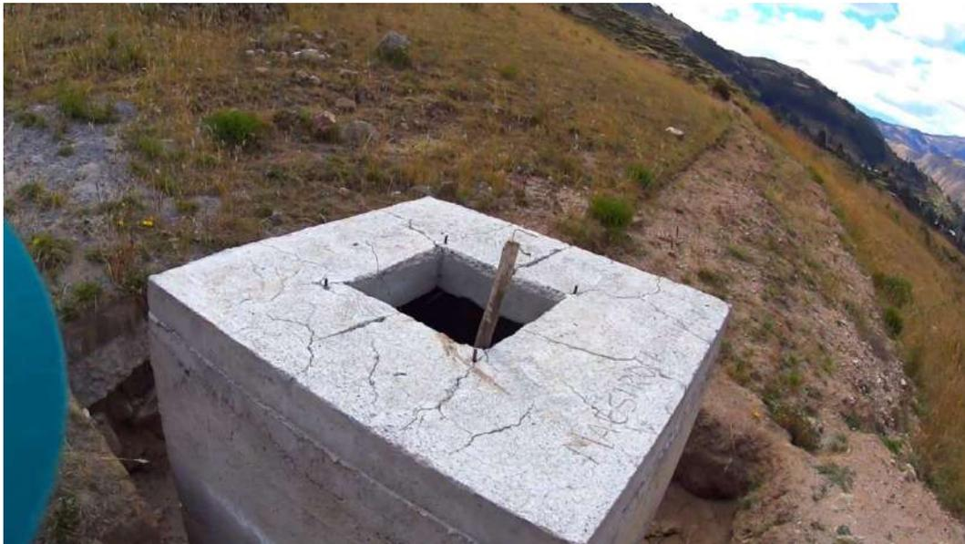
4. Cámara de inspección totalmente agrietada, mal procedimiento constructivo.
