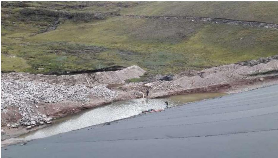
**Fig.N°03.-** Se observa, el agua empozada al pie del talud aguas arriba (el dentellón está sumergido), se ha tratado de evacuar el agua con 02
