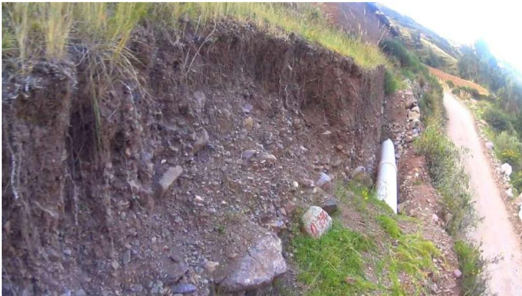
2. Tubería PVC, expuesta a los rayos solares, mal procedimiento constructivo.
