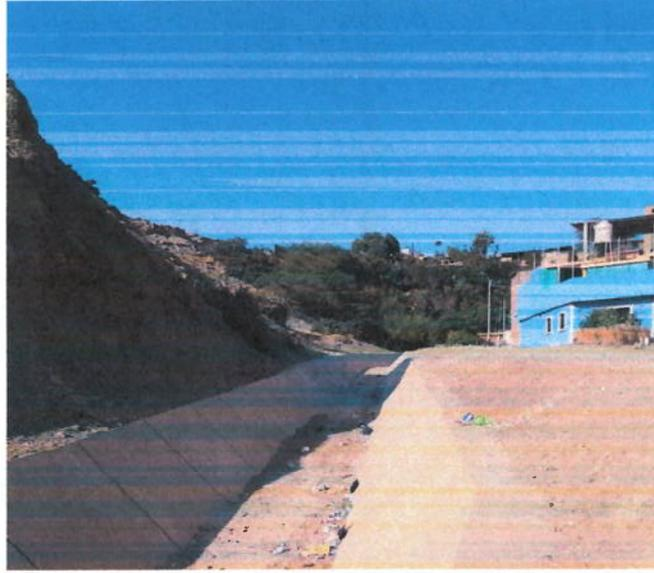
FOTO N° 4.- VISTA DE CANAL DE EVACUACION DE AGUAS PLUVIALES
