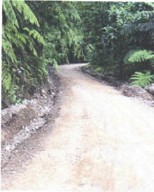
Fotografía N° 3: Nótese el regular estado de la vía, accesible a vehículos pesados.
