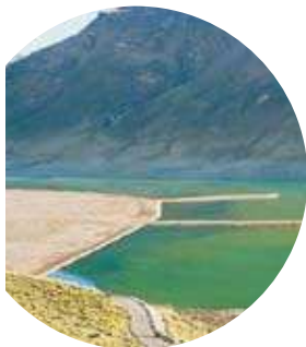
Vista superior del depósito
