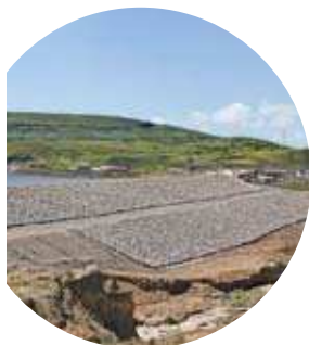
Dique del Depósito de Relaves Quiulacocha
