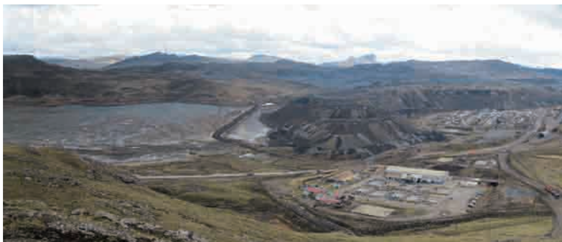
Depósito de Relaves Quiulacocha Excelsior
