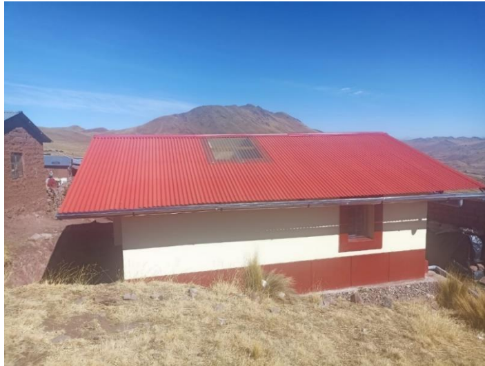
Fot. 01: Vivienda "A", 34m 2 de área, muros exteriores de albañilería de adobe, muros interiores de drywall, piso de cemento pulido, techo de calamina, cielo raso de baldosas de yeso. Teatina de policarbonato con cielo raso de baldosa alveolar translúcida.
