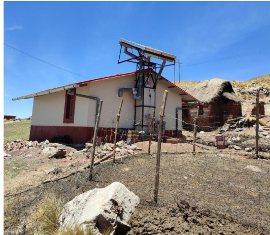
Fot. 03: Vivienda "C", 34m 2 de área, muros exteriores de albañilería de adobe, muros interiores de drywall, piso de cemento pulido en todos los ambientes, techo de estructura de madera con cubierta de calamina a dos aguas, cielo raso de baldosas de yeso, cielo raso de baldosas de yeso. Teatina de policarbonato con cielo raso de baldosa alveolar translúcida.
