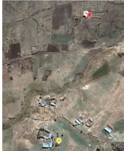
Figura 04: Ubicación de viviendas “E”, “F” y “G”, ubicadas en el Sector de Alto Nevado, Distrito de Kunturkanki, Provincia de Canas, Cusco.
