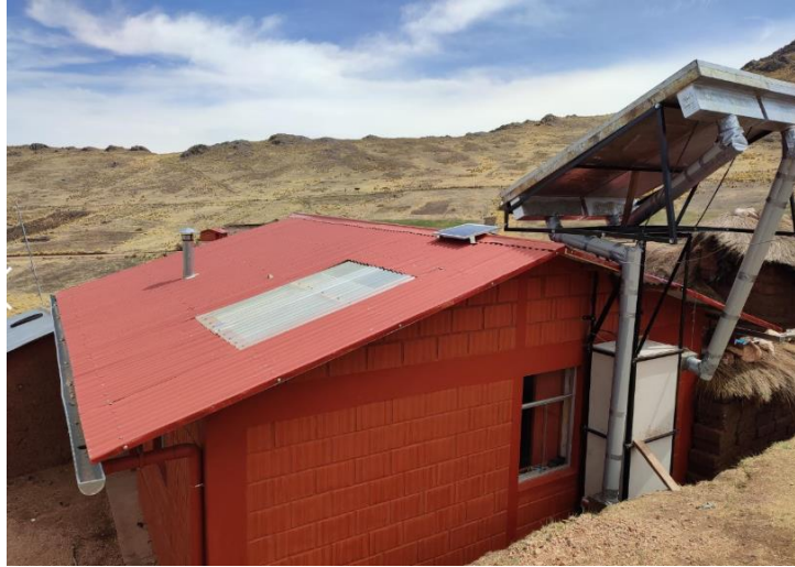
Fot. 05: Vivienda "E", 26.7m 2 de área, muros de albañilería confinada de ladrillos de arcilla, piso de cemento pulido en esclusa y sala-comedor y piso de madera machihembrada en dormitorios, techo de estructura de madera con cubierta de calamina a dos aguas, cielo raso de baldosas de yeso. Teatina de policarbonato con cielo raso de baldosa alveolar translúcida.
