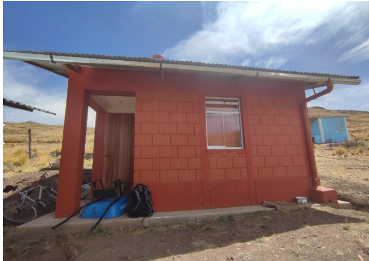
Fot. 06: Vivienda “F”, 26.7m 2 de área, muros de albañilería confinada de ladrillos de arcilla, piso de cemento pulido en esclusa y sala-comedor y piso de madera machihembrada en dormitorios, techo de estructura de madera con cubierta de calamina a dos aguas, cielo raso de baldosas de yeso. Teatina de policarbonato con cielo raso de baldosa alveolar translúcida.
