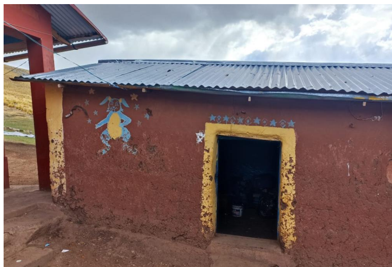
Fot. 07: Vivienda “G”, un ambiente, 16m 2 de área, muros de adobe, piso de tierra apisonada, techo de estructura de madera y cubierta de calamina.
