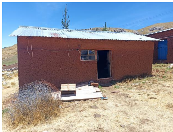
Fot. 04: Vivienda "D", de un ambiente, 16m 2 de área, muros de adobe, piso de tierra apisonada, techo de estructura de madera y cubierta de calamina.
