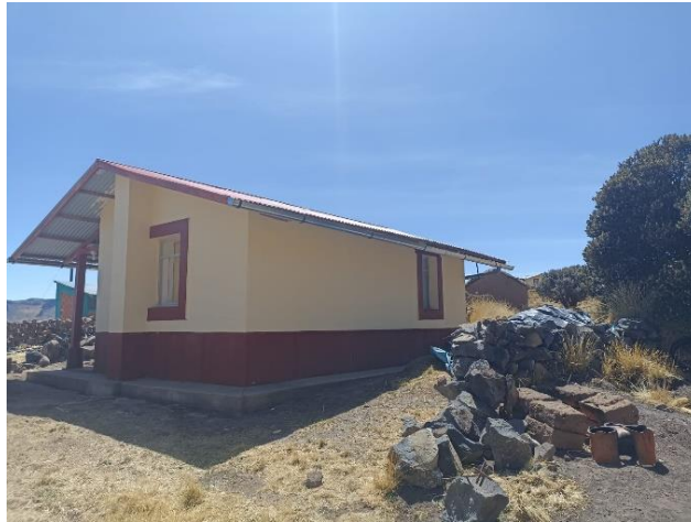
Fot. 02: Vivienda “B”, 34m2 de área, muros exteriores de albañilería de adobe, muros interiores de drywall, piso de cemento pulido en todos los ambientes, techo de estructura de madera con cubierta de calamina a dos aguas, cielo raso de baldosas de yeso. Teatina de policarbonato con cielo raso de baldosa alveolar translúcida.
