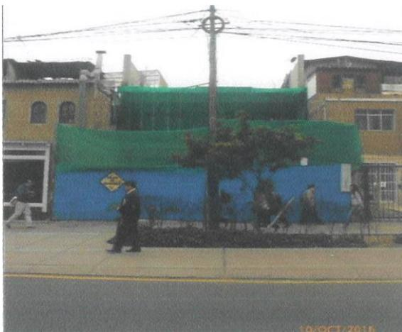
En la foto de fachada de fecha 10 de octubre de 2016, se puede visualizar que el predio se encuentra en ejecución de obra, visualizándose “pies derechos” y encofrado de vigas y losa el segundo nivel.
