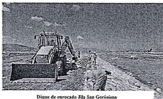
Dique de enrocado Jila San Gerónimo
