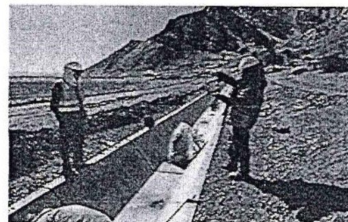
Sellado de Juntas canal de riego Sistema de Riego Sucre
