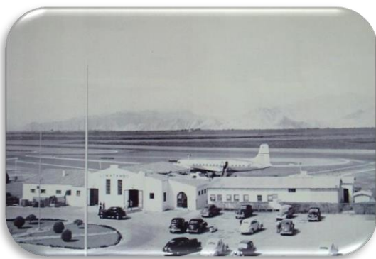
Aeropuerto Limatambo (San Isidro-Lima). 1930.
