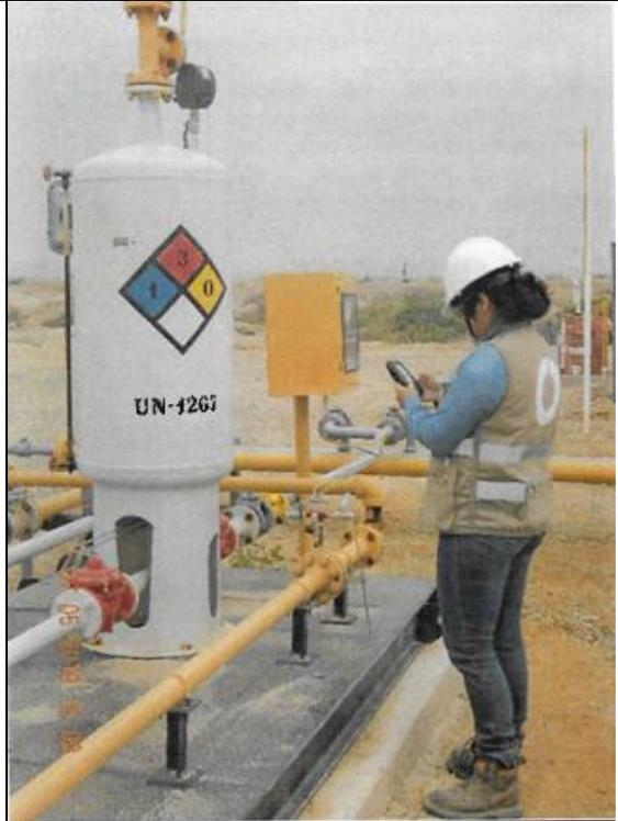
Volumeter, activo, indicador de presión 0-100 psi, controlador PLC, capacidad 1Bl.
