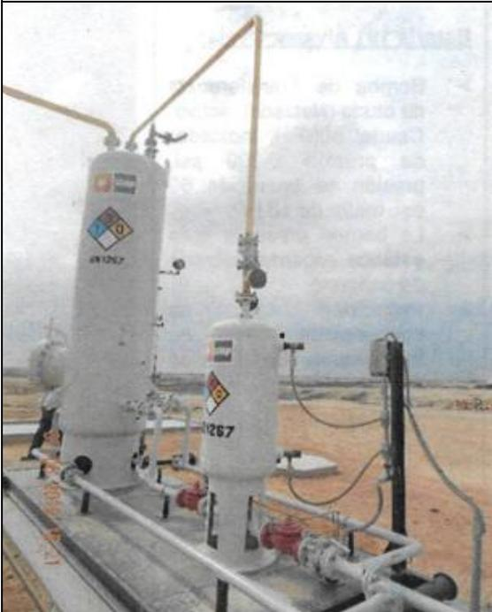
Volumeter 1, activo, Indicador de presión 0-100 psi, controlador PLC, Capacidad 1 bls.
