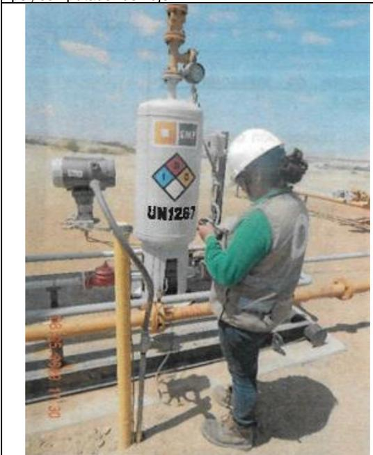
Volumeter 1: activo, indicador de presión de 0-100 psi, controlador PLC, capacidad 1 bls.
