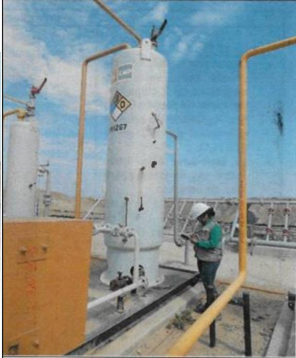
Separador de bifásico de prueba, activo, Val seguridad de 2 pulgadas, indicador de presión 0-100 psi, computador de flujo.
