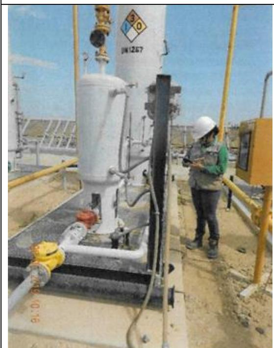
Volumeter, activo, indicador de presión 0-100 psi, controlador de PLC. Capacidad 1 Bls.
