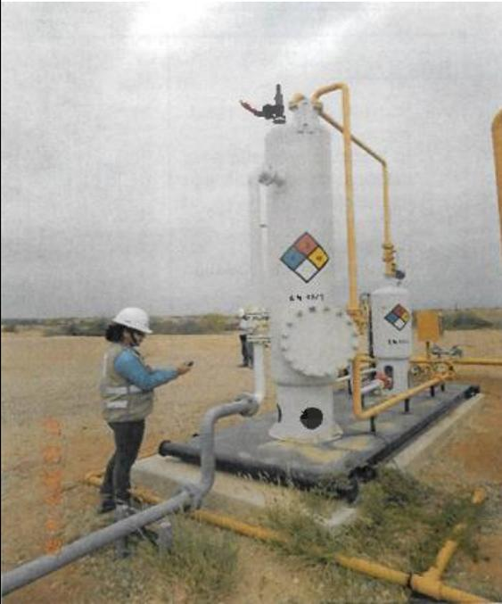
Separador de Prueba bifásico, activo, válvula de seguridad de 2 pulgadas, indicador de presión 0-100 psi, computador de flujo.
