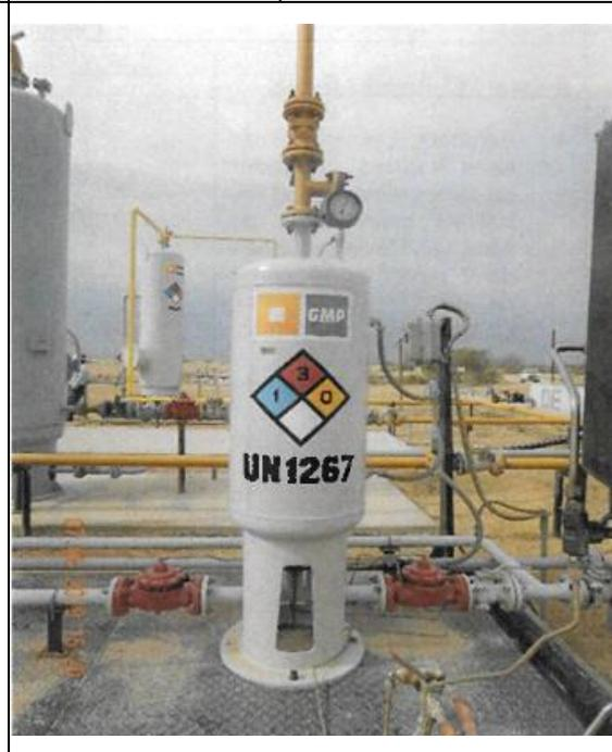
Volumeter 3, activo, Indicador de presión 0-100 psi, controlador PLC, Capacidad 2 bls.
