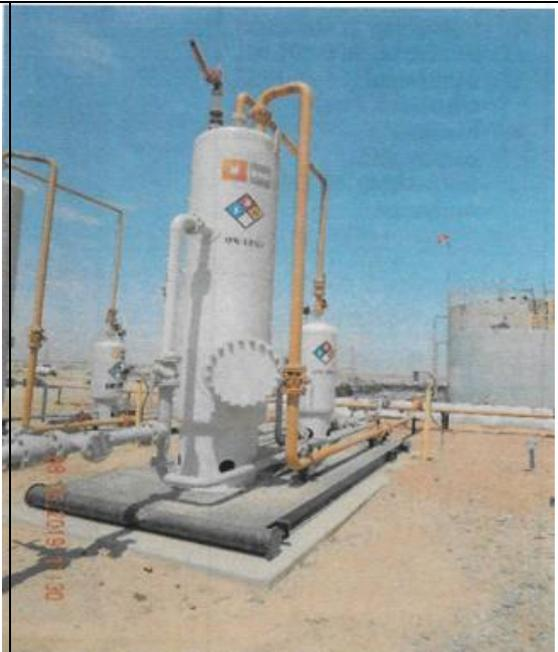
Separador 2: Separador bifásico de Totales, activo, válvula de seguridad de 2 pulgadas, Indicador de presión 0-100 psi, computador de flujo.
