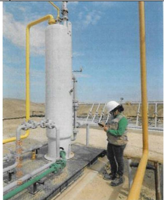
Separador de bifásico de prueba, activo, válvula de seguridad de 2 pulgadas, indicador de presión 0-100 psi, registrado de presión diferencial de 100 psi x 100 H<sub>2</sub>O.
