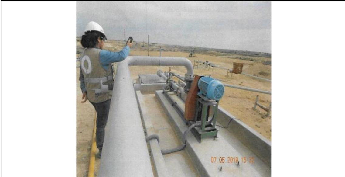
Bomba de Transferencia de crudo (Netsch), activo, Caudal 60BPH, Indicador de presión 0-300 psi, presión de operación 60 psi, motor de 18 HP.
