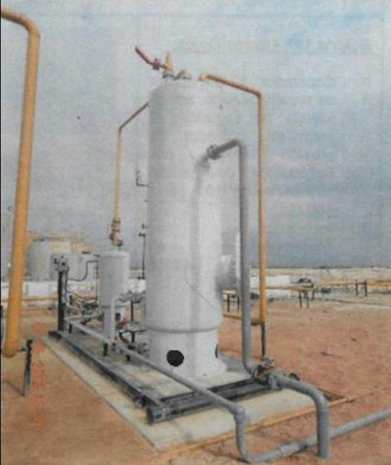
Separador 1: Separador de prueba bifásico, activo, válvula de seguridad 2 pulgadas, indicador de presión 0-100 psi, computador de flujo.
