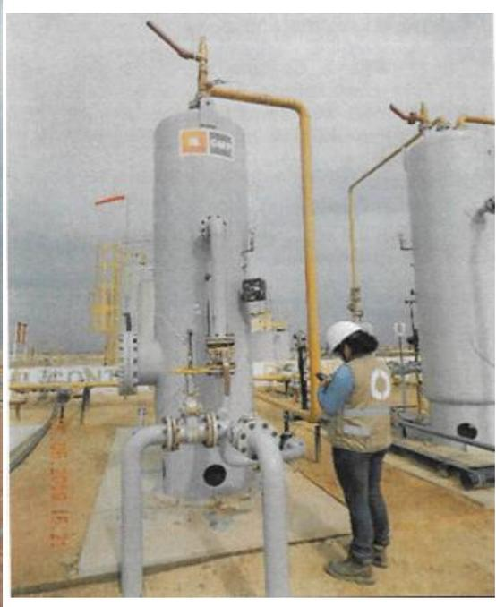
Separador 2: Separador de Totales bifásico, activo, válvula de seguridad 2 pulgadas, indicador de presión 0-100 psi, Indicador de Flujo Floco F-500, Válvula controladora de niveles.
