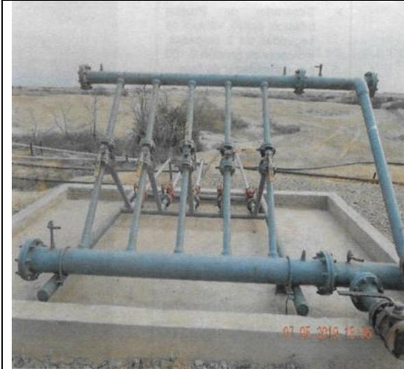
Manifold de Batería 191-1, activo, 5 salidas con área estanca impermeabilizada con concreto.
