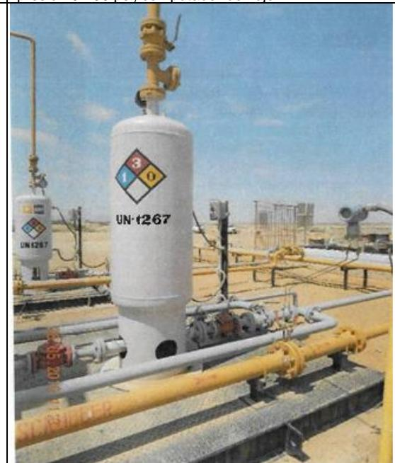
Volumeter 2: indicador de presión de 0-100 psi, controlador PLC, capacidad 2 bls.
