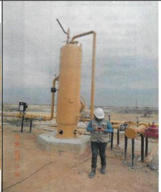
Scrubber: Controlador de Nivel Norriseal, indicador de temperatura 0-250 oF, Válvula controladora de nivel, válvula de seguridad de 2 pulgadas, indicador de presión 0-100 Psi, Computador de flujo, indicador de nivel y válvula, controladora de presión.
