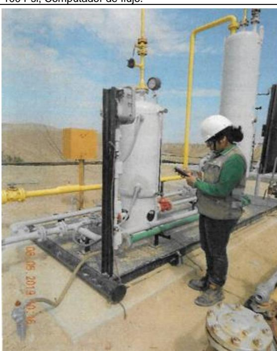
Volumeter, activo, indicador de presión 0-100 psi, controlador de PLC. Capacidad 2 Bls.
