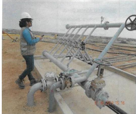
Manifold 2 de batería 191 (cinco salidas) con lecho impermeabilizado con concreto
