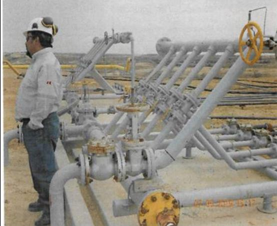
Manifold 1 de batería 191 (cinco salidas) con lecho impermeabilizado con concreto
