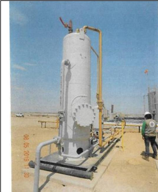
Separador 1: Separador de prueba bifásico, activo, válvula de seguridad de 2 pulgadas, Indicador de presión 0-100 psi, computador de flujo.
