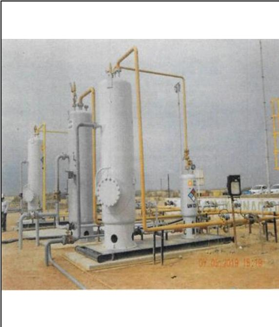
Separador 3: Separador de prueba bifásico, activo, válvula de seguridad 2 pulgadas, indicador de presión 0-100 psi, Registrador de presión diferencial de 100 psi x 100 H2O.
