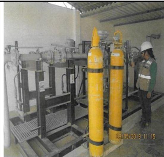
Unidad LACT de rechazo, DN3 x 300 # RF, activo, Presión de Operación 70-150 Psig, Presión de diseño 500 Psig, Temperatura de operación 60-120 OF, Temperatura de Diseño 120 OF, Caudal 600-2000/3500-2500 BPD.
