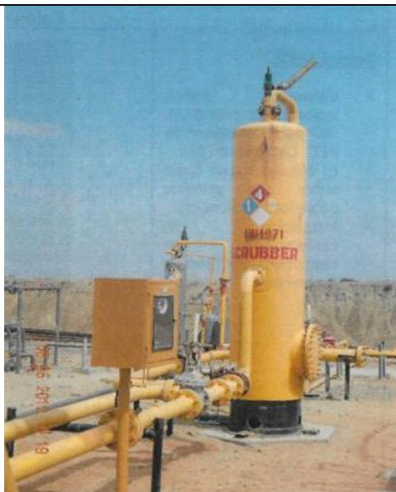
Scrubber: Activo, control de nivel Norriseal, Indicador de Temperatura 0-250 °F, válvula Controladora de Nivel, válvula de seguridad de 2 pulgadas, indicador Presión 0-100 Psi, Computador de flujo.
