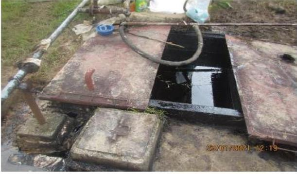
Se observa el tanque sumidero de la Locación 1A del Yacimiento San Jacinto. Las constantes precipitaciones en la zona llevaron a que el tanque sumidero se acumule con agua pluvial en su interior, por lo que el hidrocarburo remanente se fue desplazando por diferencia de densidades hasta el punto de rebasar la capacidad de almacenamiento del tanque sumidero, afectando el componente suelo y vegetación del área adyacente a dicho tanque.
