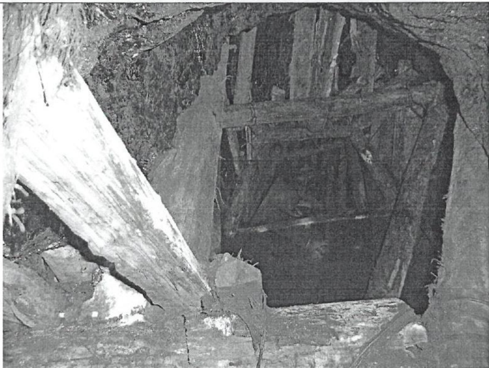
Subnivel de la Galería Rocío – Lugar del accidente
