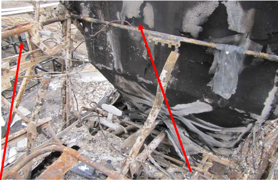
Spray Valve en posición "Cerrado", ubicación del panel de instrumentos dañado por el incendio.
