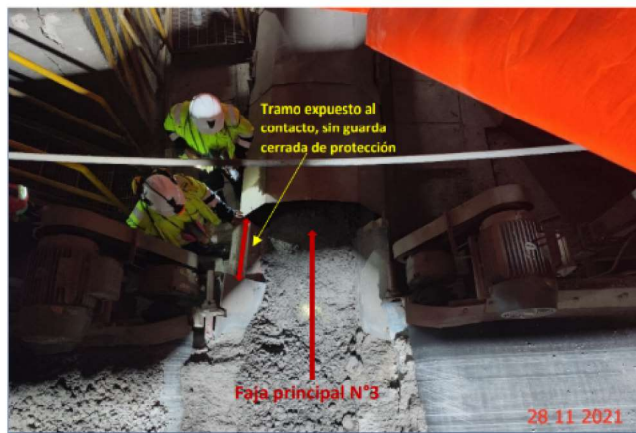
Fotografía N° 7 Vista en planta del trayecto de la faja principal N° 3 y del tramo expuesto al contacto, sin guarda cerrada de protección.
