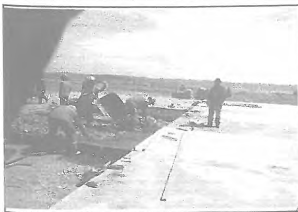
Descripción: Se observa realizando el vaciado de paños
