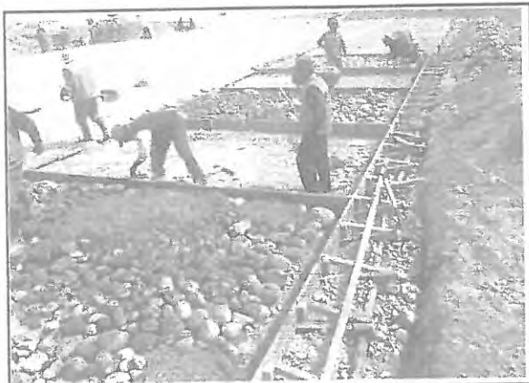
Descripción: Se observa el encofrado de los paños a vacear
