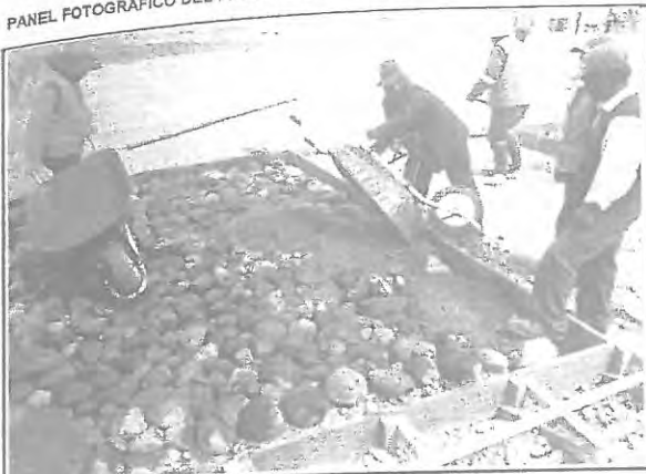
Descripción: Se observa el inicio del vaciado de los paños
