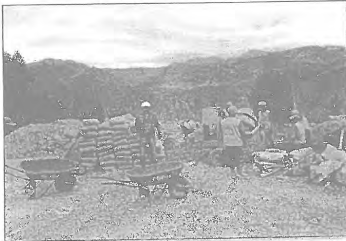
CONTROL DE LA DOSIFICACION DEL CONCRETO.
