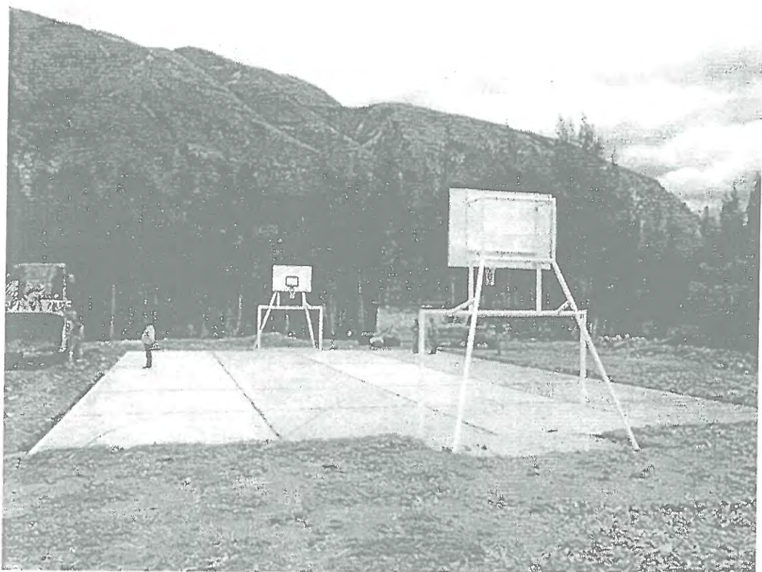
VISTA LOSA CONCLUIDA MAS LOS ARCOS 2
