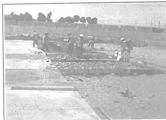
Descripción: Se observa el empedrado para el vaciado de paños
