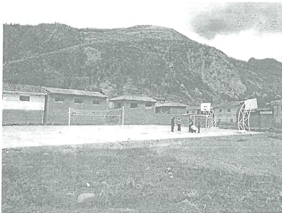
SE PUEDE OBSERVAR INFRAESTRUCTURA DEPORTIVA CONCLUIDA
