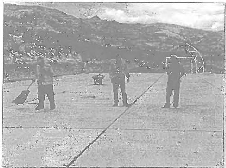
VERIFICACION DE LOS TRABAJOS POR PARTE DEL ING. SUPERVISOR.
