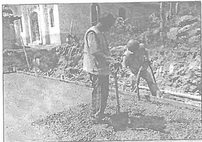
VIBRADO DE CONCRETO EN EL QUINTO CARRIL
