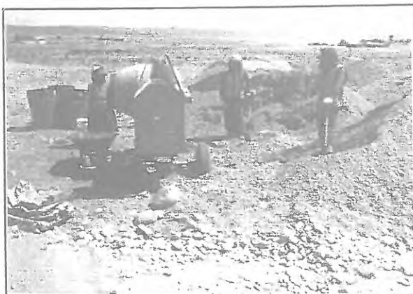
Descripción: Se observa preparando la mezcla para el vaciado de paños
