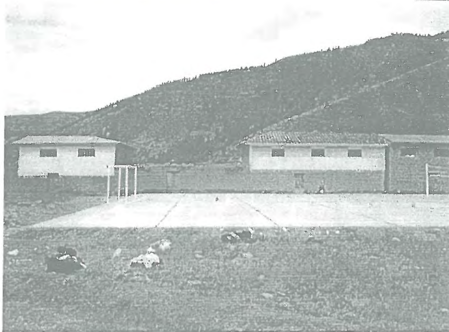
VISTA LATERAL DE LOSA CONCLUIDA
