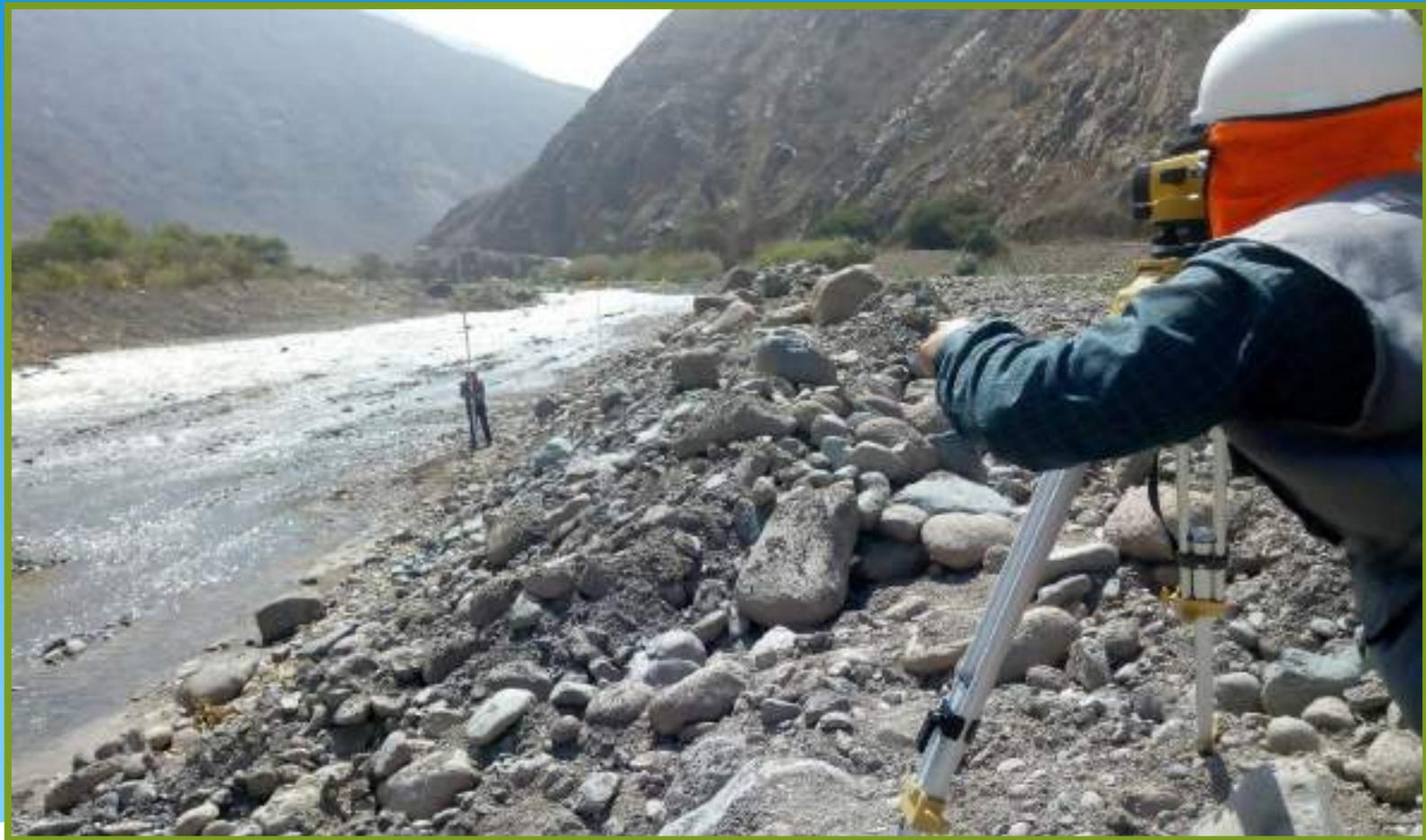
**FOTO 02:** VISTA PANORÁMICA DEL CONTROL DE NIVELES TOPOGRÁFICOS “CORTE Y RELLENO”
