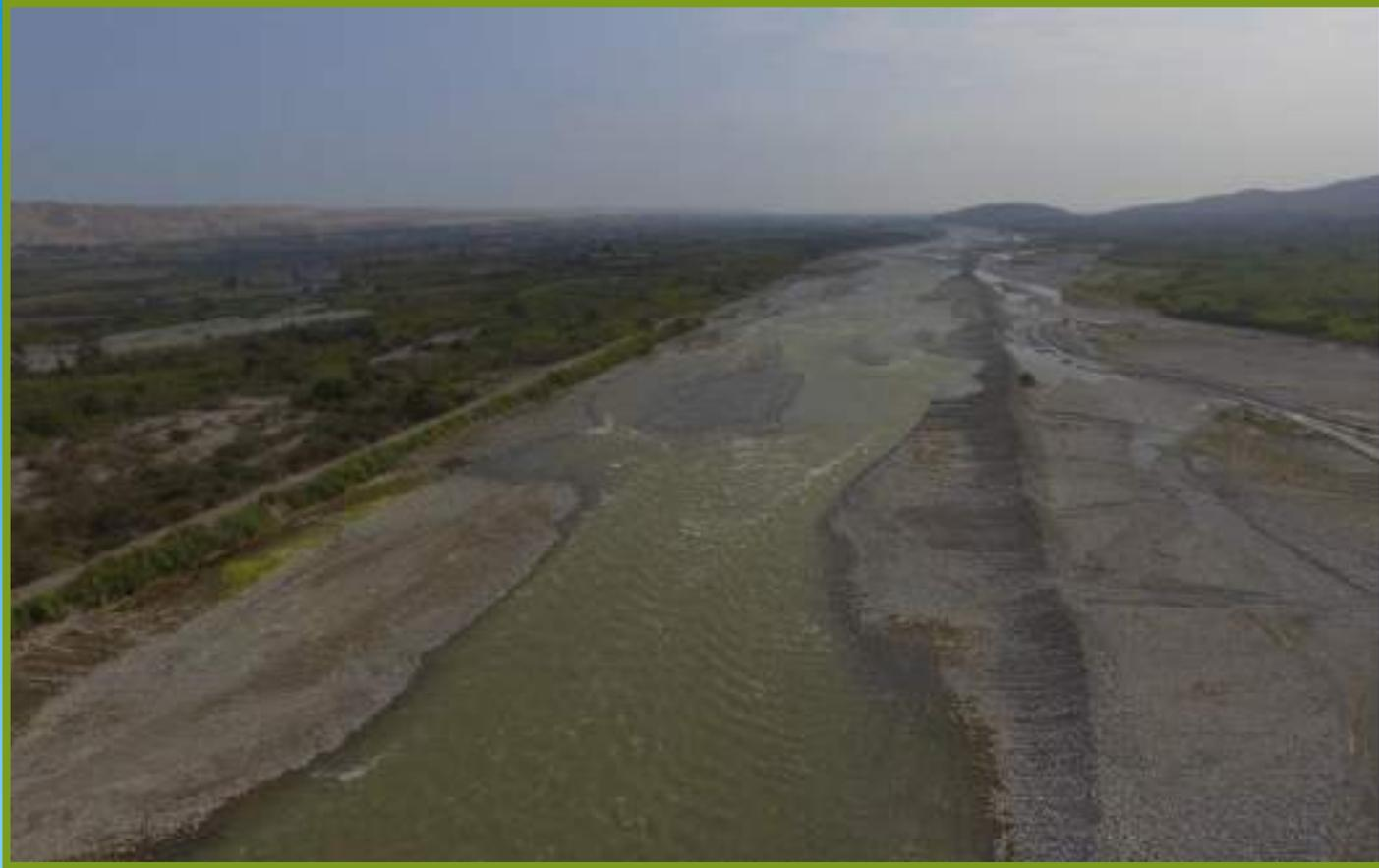
**FOTO N°09:** CULMINACIÓN DE LOS TRABAJOS (LIMPIEZA, DESCOLMATACIÓN Y ARRIMADO DEL MATERIAL A AMBOS LADOS DEL RIO, CON UN ANCHO DE SECCIÓN DE 120 METROS O MÁS.), EN EL TRAMO V.
