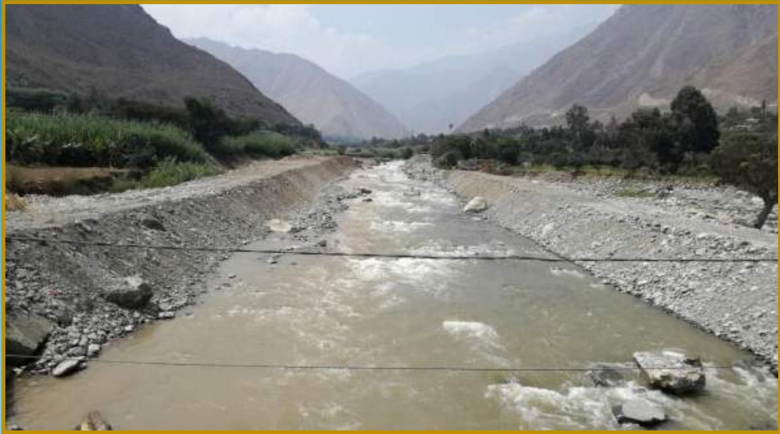
**FOTO N°08:** DESPUES DE LAS LABORES DE LIMPIEZA Y DESCOLMATAACION EN LAS PROGRESIVAS 49+030
