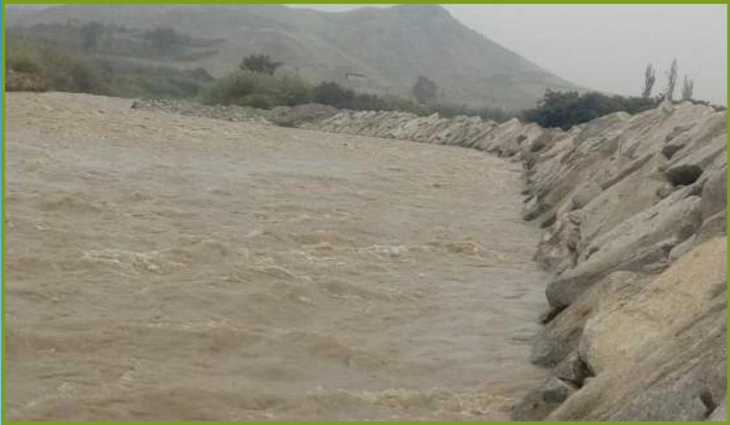
**FOTO N°06:**VISTA DEL ESTADO ACTUAL, DESPUÉS DE LA INTERVENCIÓN DE LA ACTIVIDAD DE ROCA AL VOLTEO.
