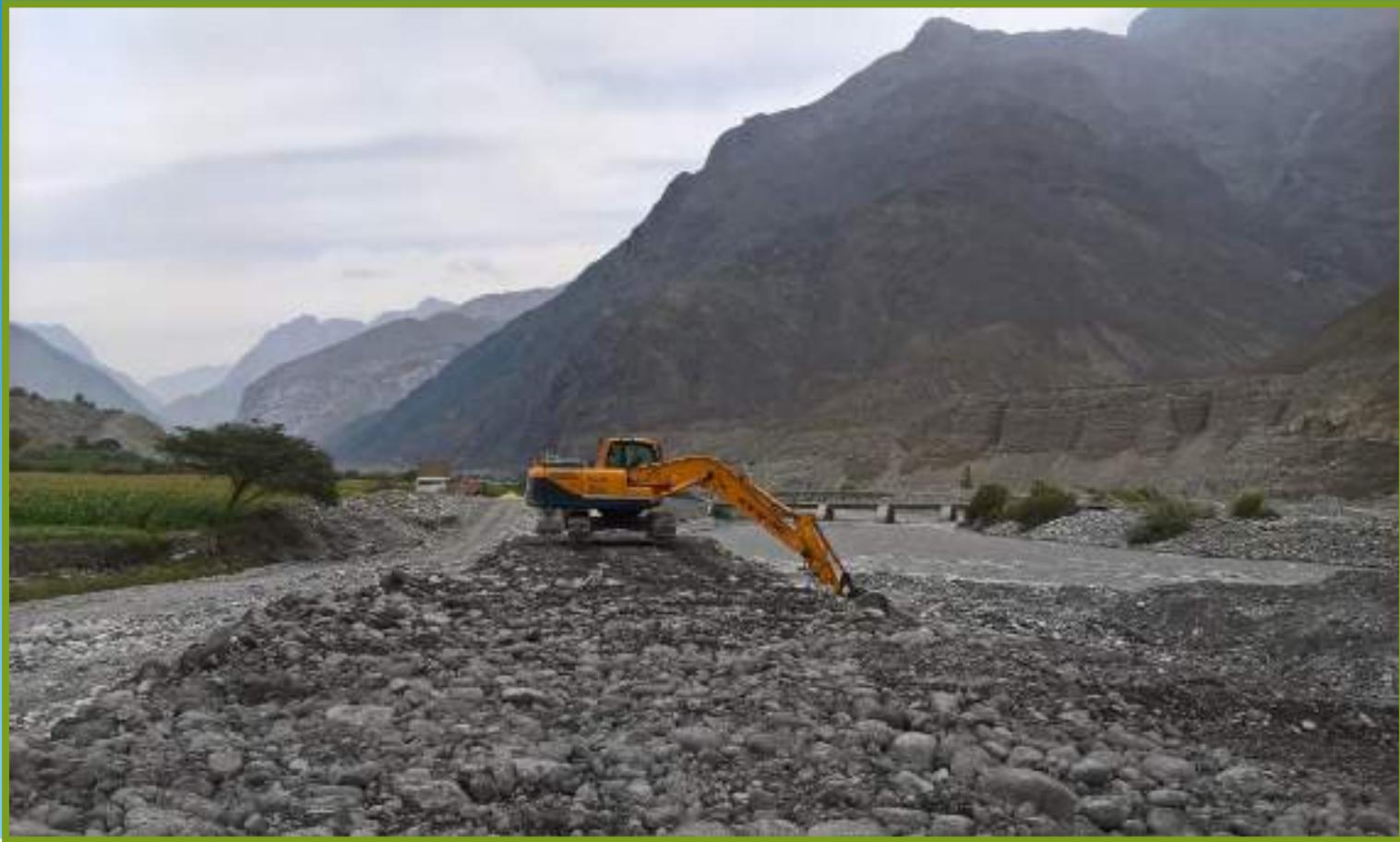
**FOTO N°05:** TRABAJOS DE CONFORMACION DE DIQUE EN EL
