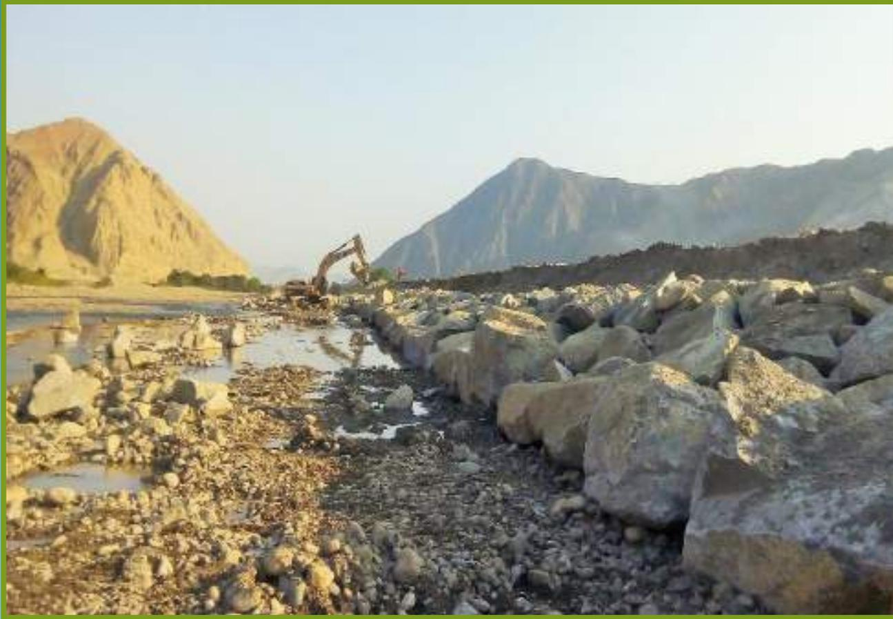
**FOTO 06:** ACOMODO DE ROCA EN EL TALUD DEL DIQUE DE LOS TRAMOS CRÍTICOS.
