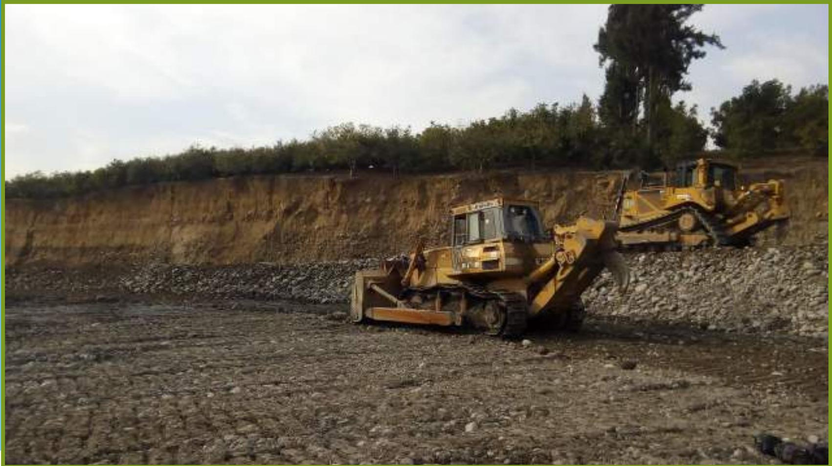
**FOTO N°04: TRABAJO DE REFINE Y CONFORMACION DE DIQUE**
