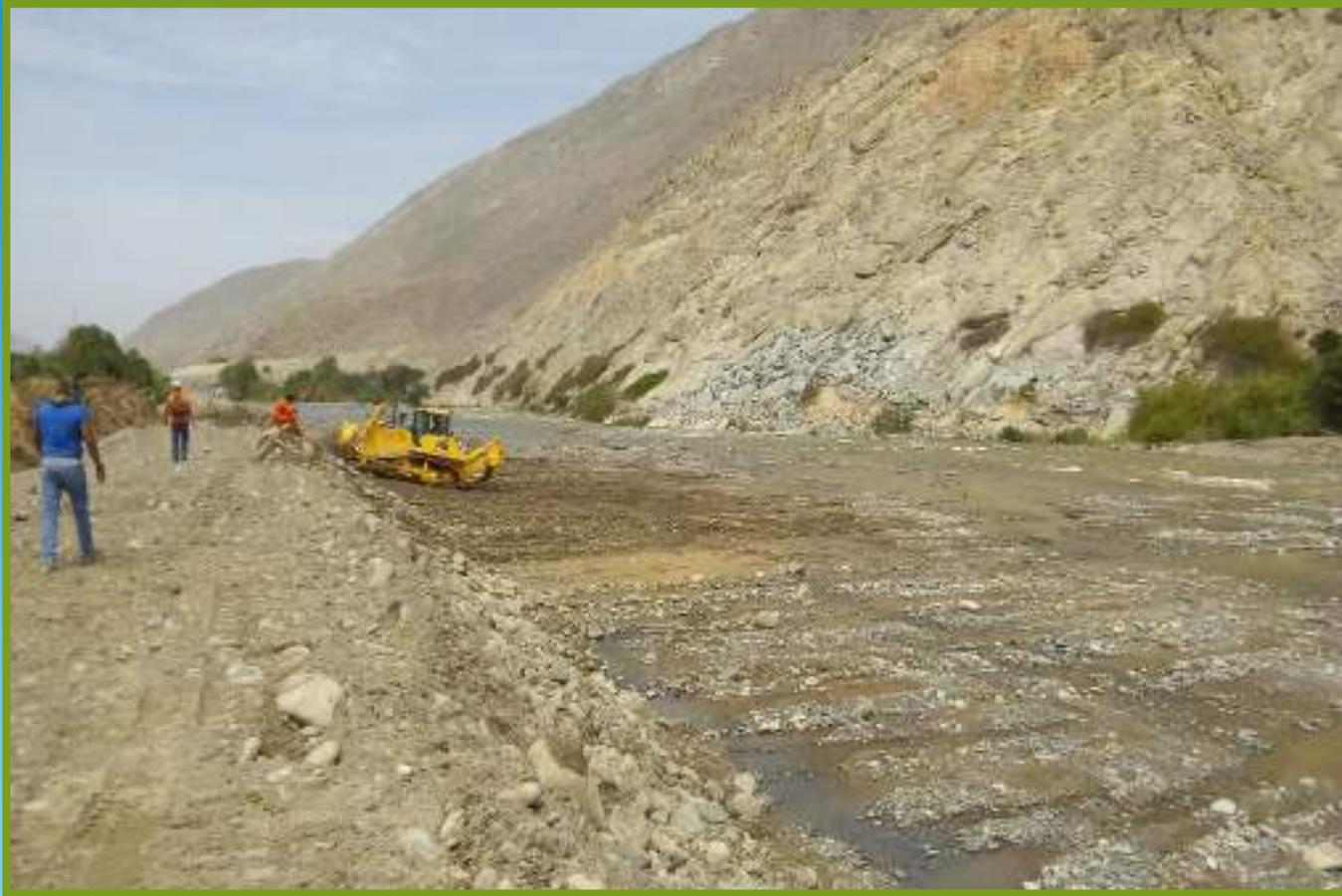
**FOTO 04:** TRABAJOS DE BARRIDO DEL CAUCE Y PERFILADO DE LA SECCIÓN DEL DIQUE.
