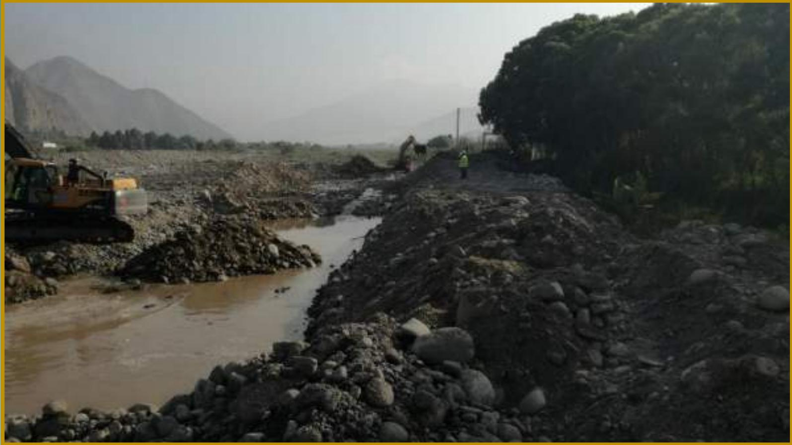
**FOTO N° 04:** MEDIANTE LAS LABORES DE LIMPIEZA Y DESCOLMATACION DEL RIO CHILLON SE ESTA DANDO UN ENCAUZAMIENTO AL RIO.
