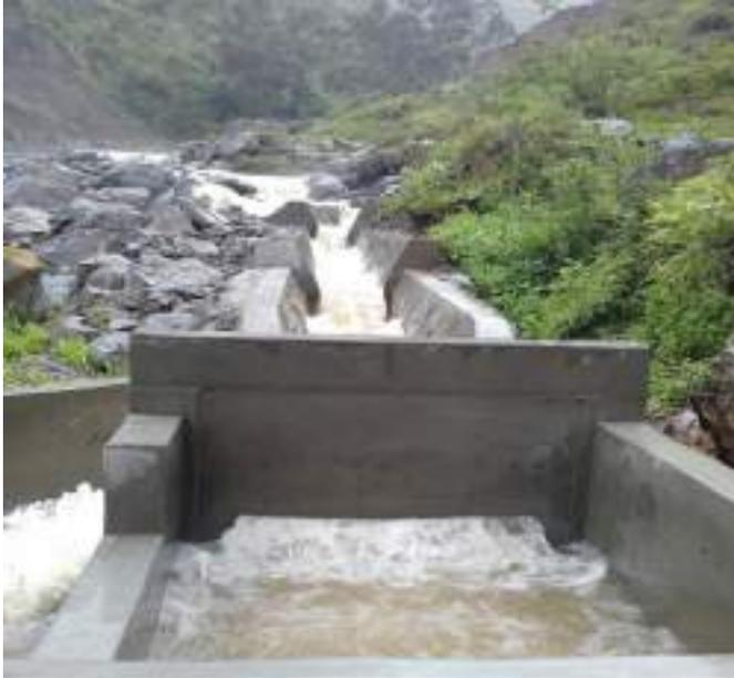
**Captación y desarenador en funcionamiento**
