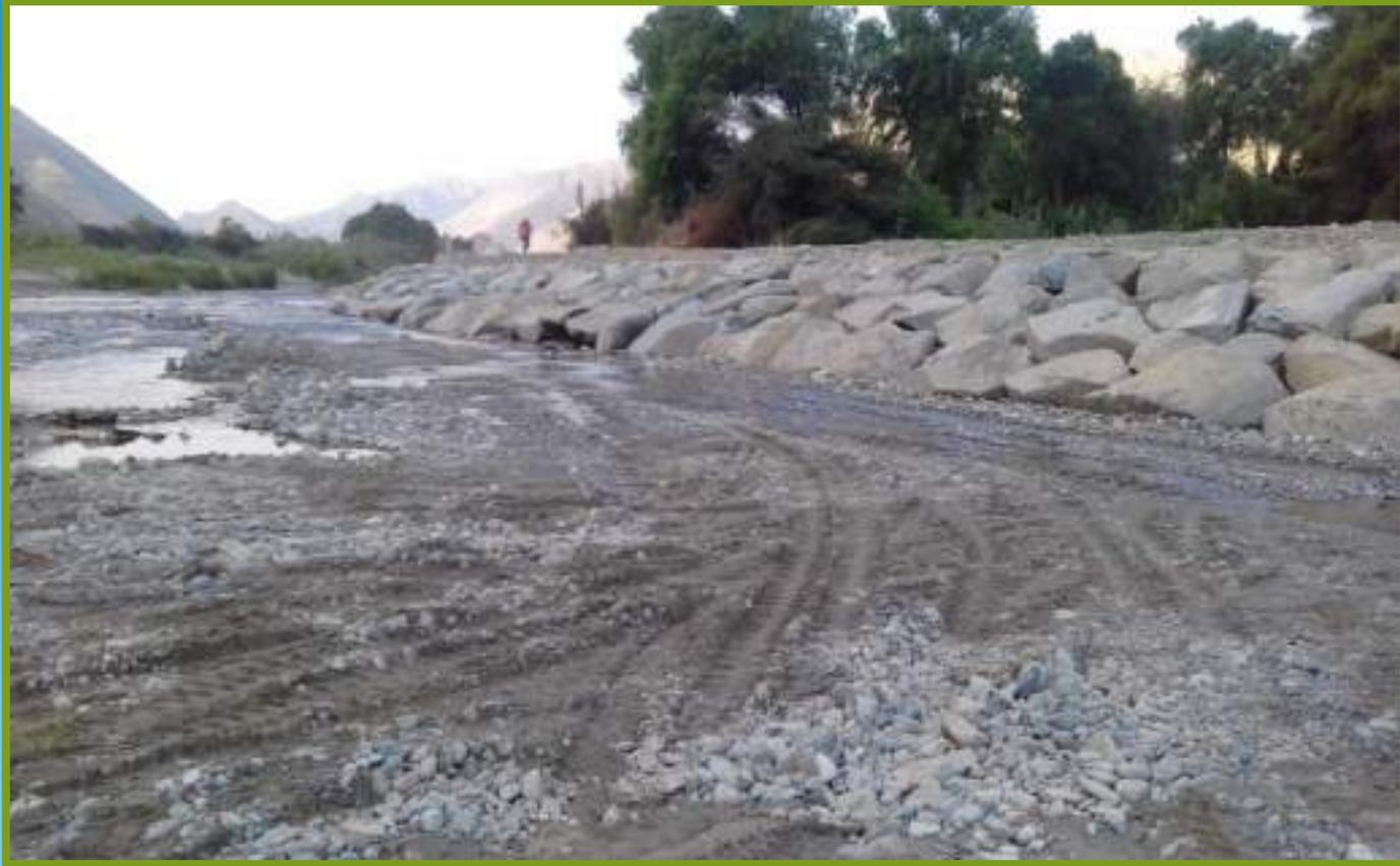
**FOTO 09:** COLOCACIÓN DE ROCA EN EL SECTOR HUARICANGA Y CAPTACIÓN DEL MINERODUCTO.
