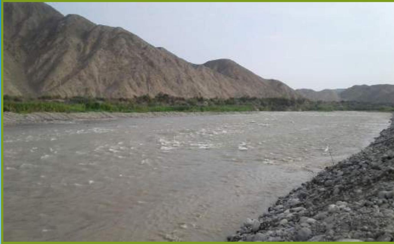
**FOTO N°11:** CULMINACIÓN DE LOS TRABAJOS (LIMPIEZA, DESCOLMATACIÓN Y ARRIMADO DEL MATERIAL A AMBOS LADOS DEL RIO, CON UN ANCHO DE SECCIÓN DE 120 MTS O MÁS.), EN EL SECTOR CALTOPILLA.
