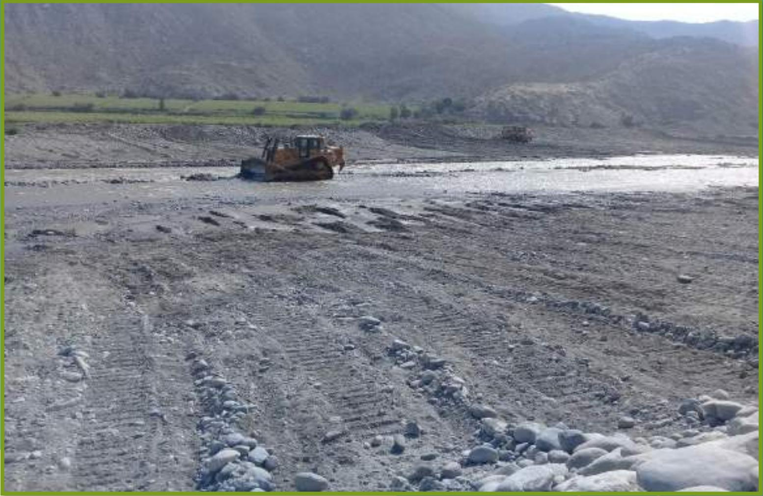
**FOTON°03:** ENCAUZAMIENTO DE LAS AGUAS BAJAS EN EL EJE DEL RIO Y TRABAJOS DE CORTE Y ARRIMADO
