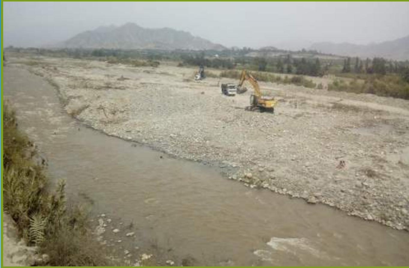
**FOTO N°04:** INICIO DE LOS TRABAJOS DE DESCOLMATACION AGUAS ARRIBA DEL PUENTE PALPA.
