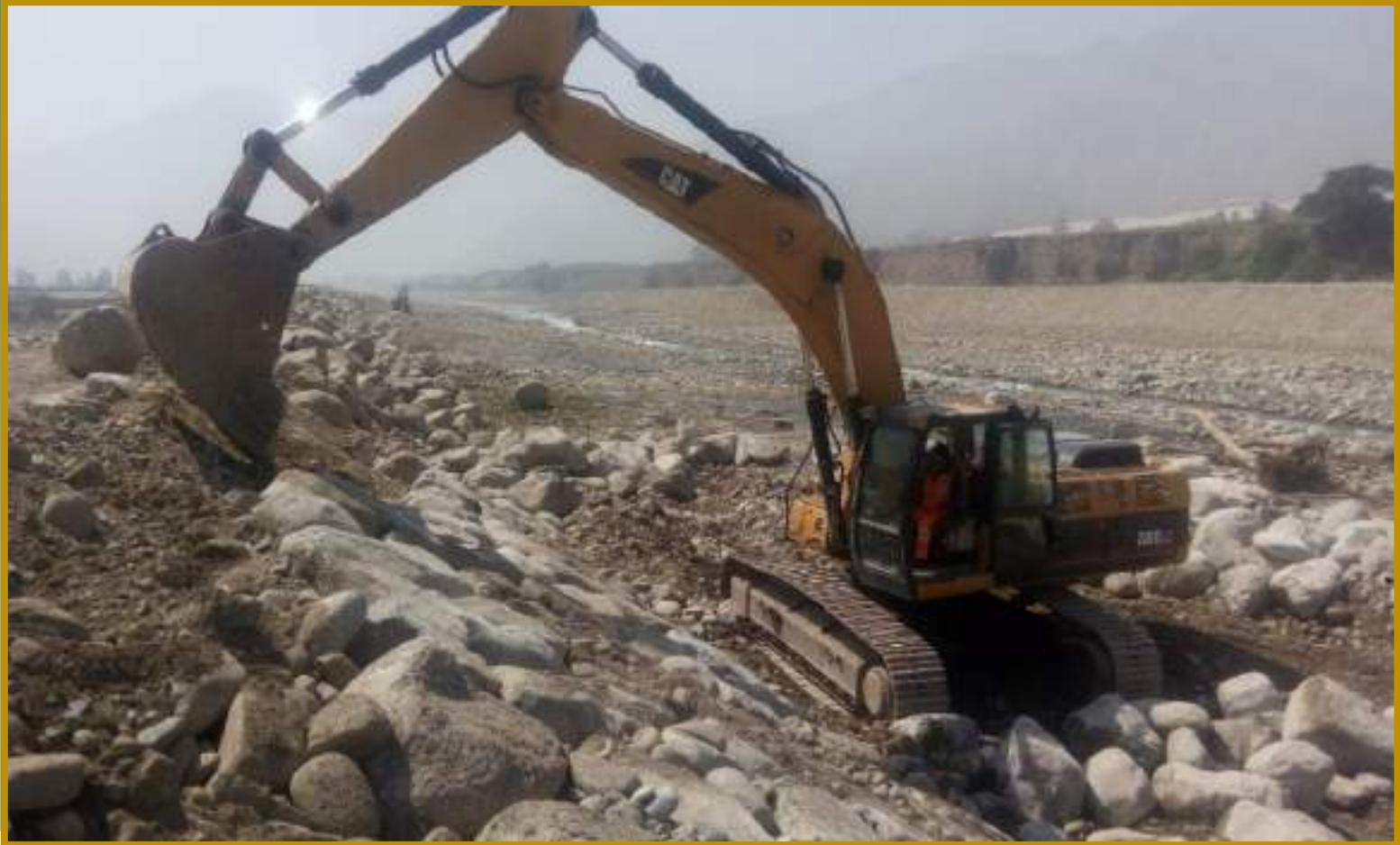
**FOTO N°06:** TRABAJOS DE ROCA AL VOLTEO DESDE EL PUENTE ZAPAN HACIA AGUAS ARRIBA QUE ESTAN EN LAS PROGRESIVAS (38+580 - 39+080)
