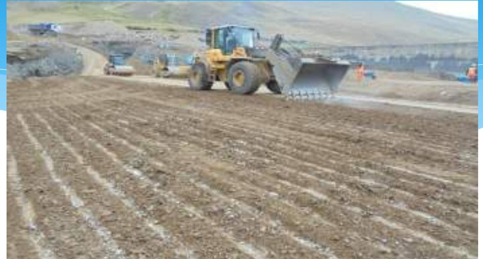
**Rasgado de la capa para continuar con el relleno.**
