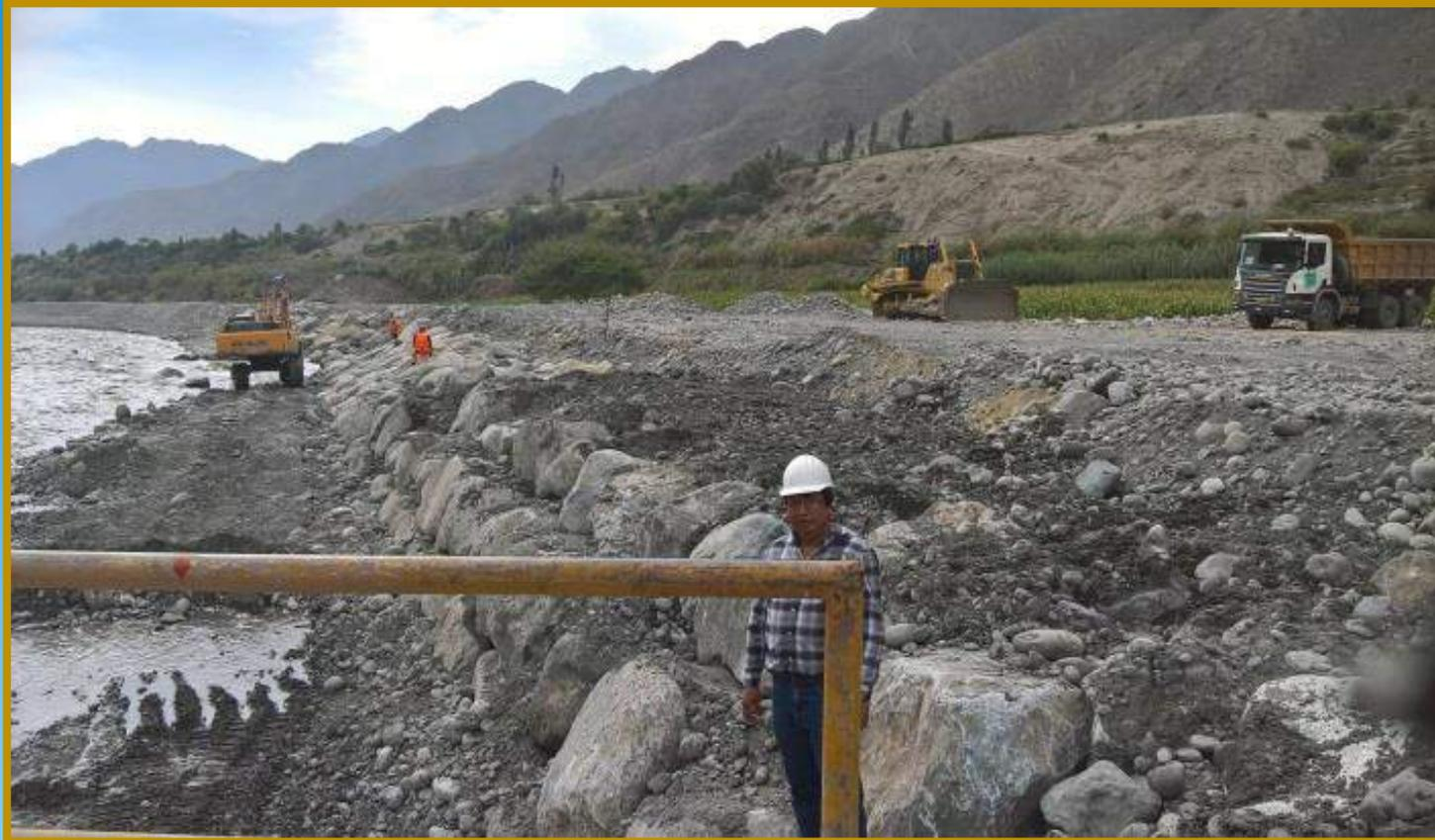
**FOTO N° 09:** TRABAJOS REALIZADOS REFERENTE A COLOCACION DE ROCA
