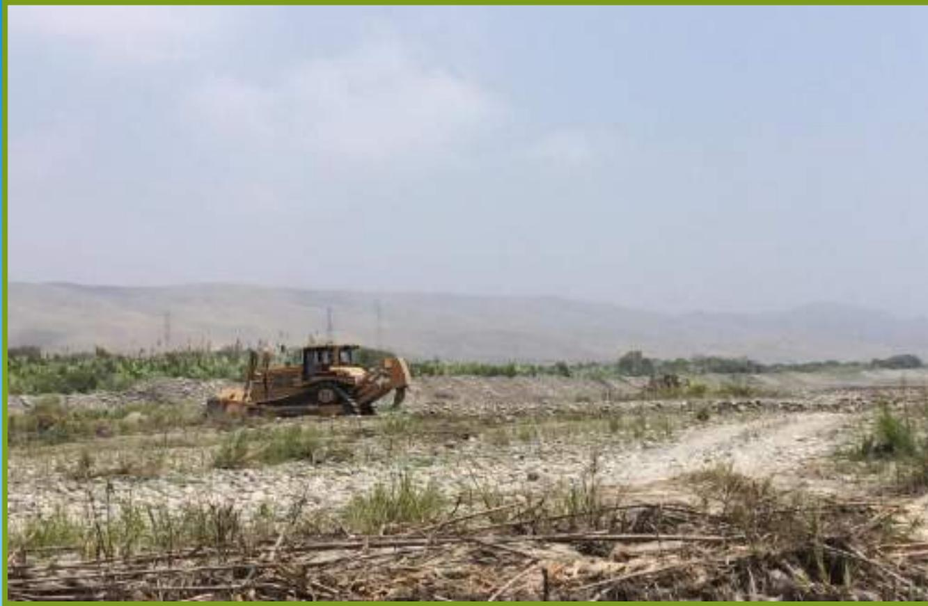
**FOTO N°01:** INICIANDO LOS TRABAJOS DE DESCOLMATACIÓN Y FORMACIÓN DEL DIQUE EN EL TRAMO IV, (10+140 A 13+520)
