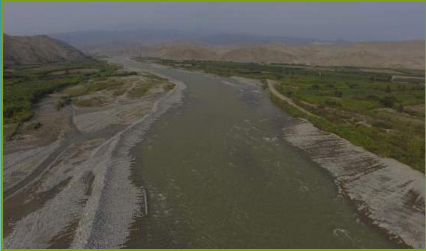
**FOTO N°10:** CULMINACIÓN DE LA LIMPIEZA Y DESCOLMATACIÓN DEL RÍO CAÑETE, SECTOR SAN CARLOS, DESDE LA PROGRESIVA 14+700 HASTA LA PROGRESIVA 16+900.
