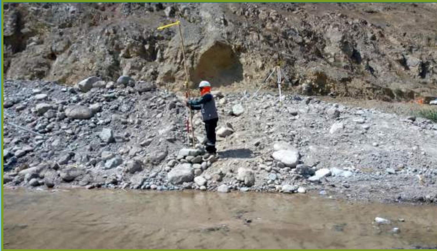
**FOTO N° 01:** REPLANTEO TOPOGRAFICO “COLOCACIÓN DE BANDERIN EN PIE DE TALUD – CARA HUMEDA DE LA DEFENSA RIBEREÑA”
