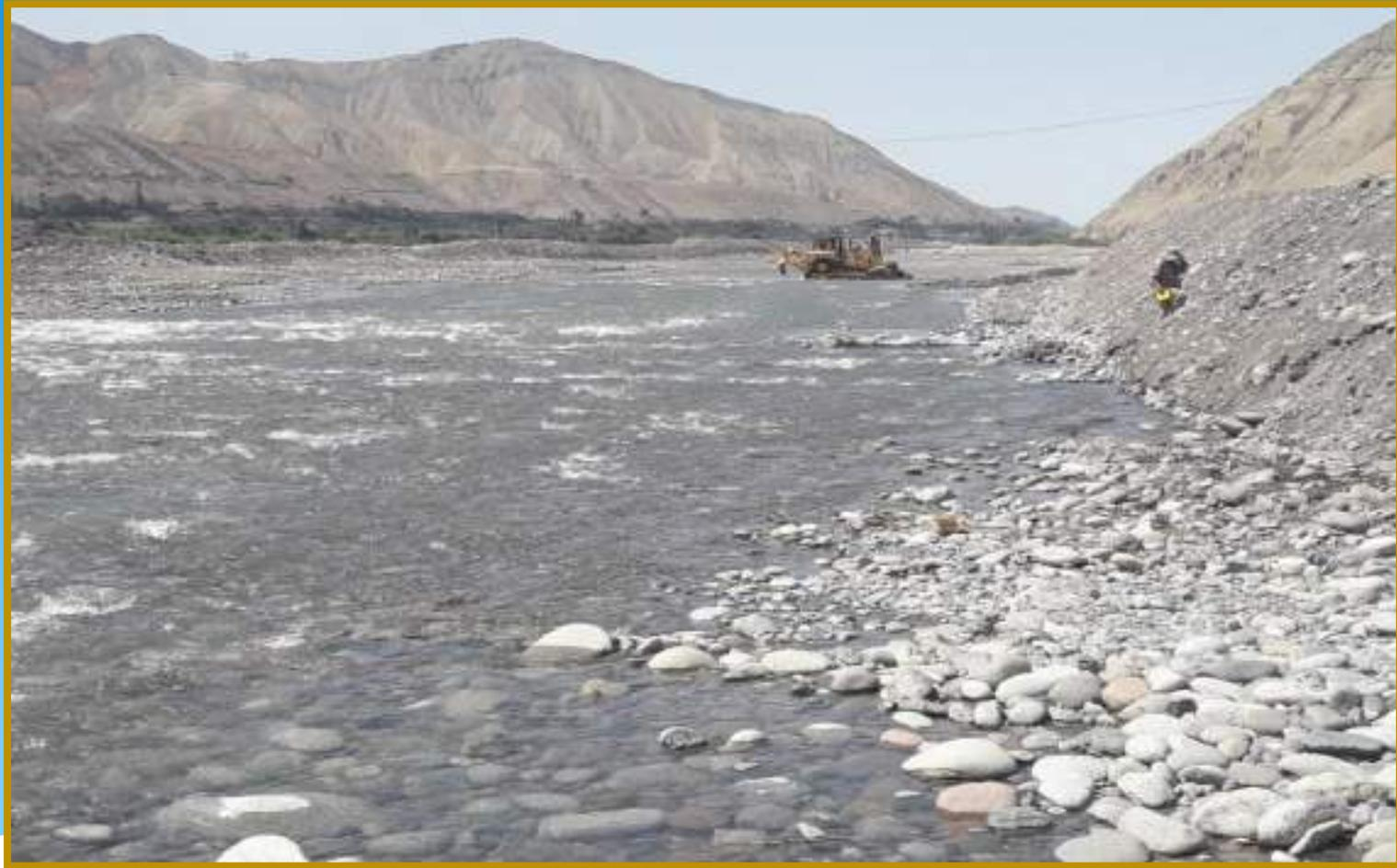
**FOTO N°02:** ZONA DE PROGRESIVA 16+350, DESCOLMATADO Y ENCAUZAMIENTO DEL EJE DEL RIO.
