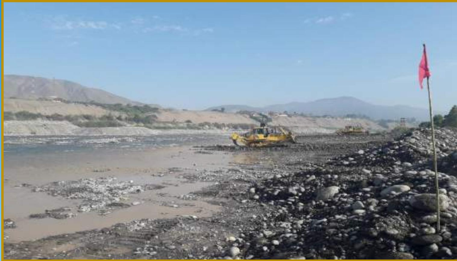
**FOTO N°03:** COLOCACION DE BANDERINES PARA INICIO Y FINAL DE ZONA DE ROCA AL VOLTEO. MARGEN DERECHO.
