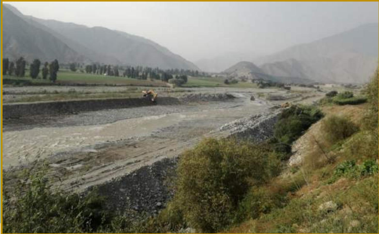
**FOTO N°05:** LA CONFORMACIONES DE DIQUE Y ENCAUSAMIENTO DEL RIO CHILLON EN LA PROGRESIVAS 39+500
