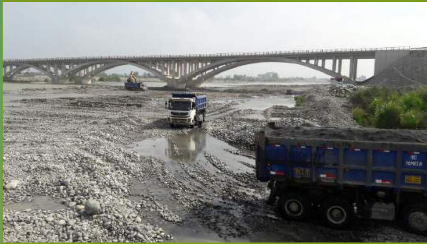
**FOTOGRAFÍA N° 06:** TRAMO I (0+000 A 3+380), MATERIAL EXCEDENTE TRASLADO EN LOS VOLQUETES.
