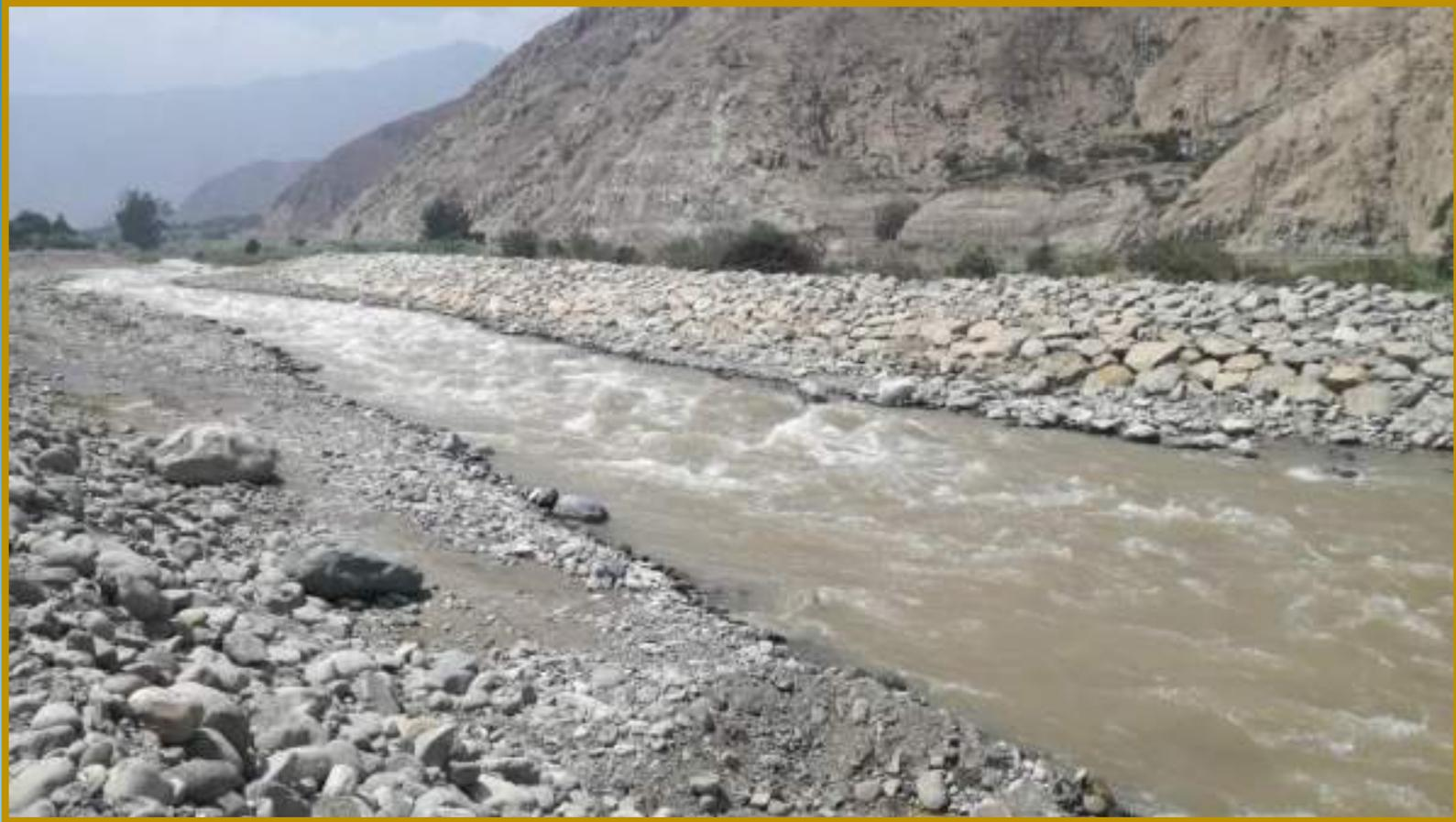
**FOTO N°07:** CULMINACION DE LA COLOCACION DE ROCA AL VOLTEO EN EL TRAMO III
