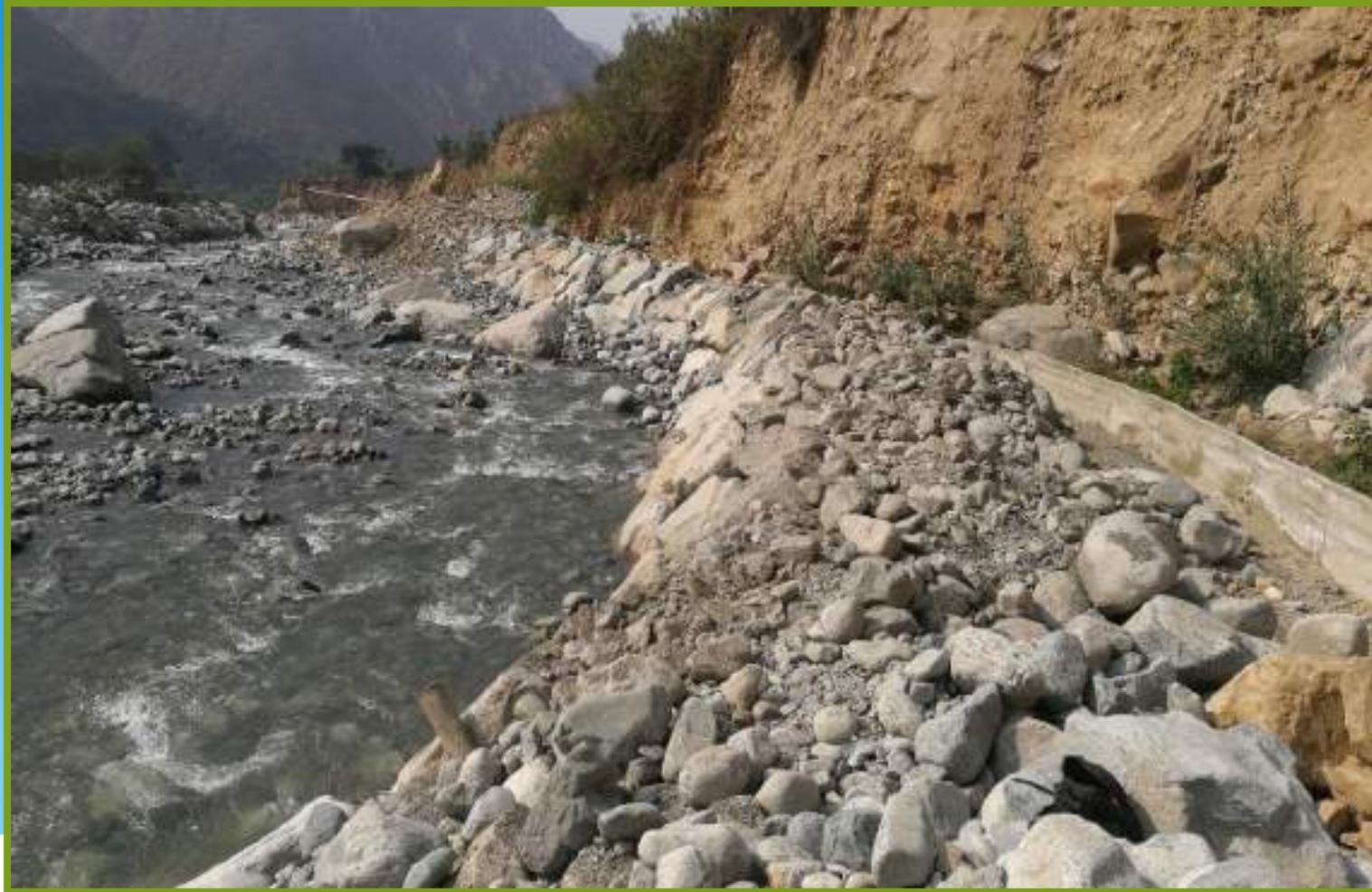
**FOTO N°03:** ROCA AL VOLTEO EN PROTECCION DE CAPTACION DE AGUA TRAMO 3
