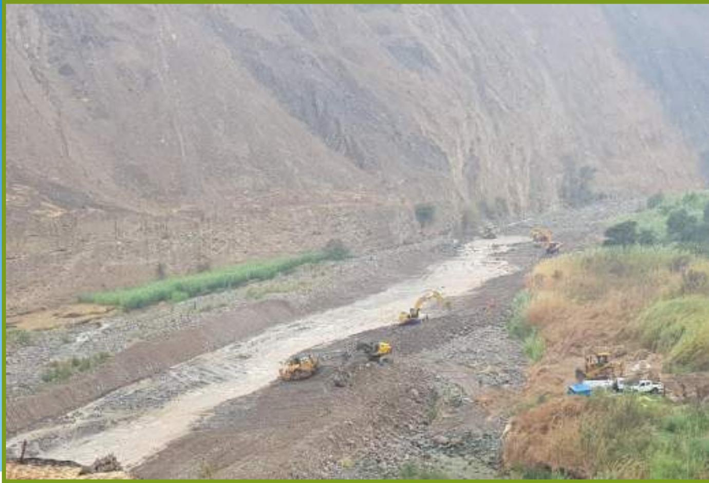
**FOTO N°05:** SE PUEDE OBSERVAR LOS TRABAJOS DE CORTE Y ARRIMADO DESDE LA PROGRESIVA 56+650 HASTA LA PROGRESIVA 57+200
