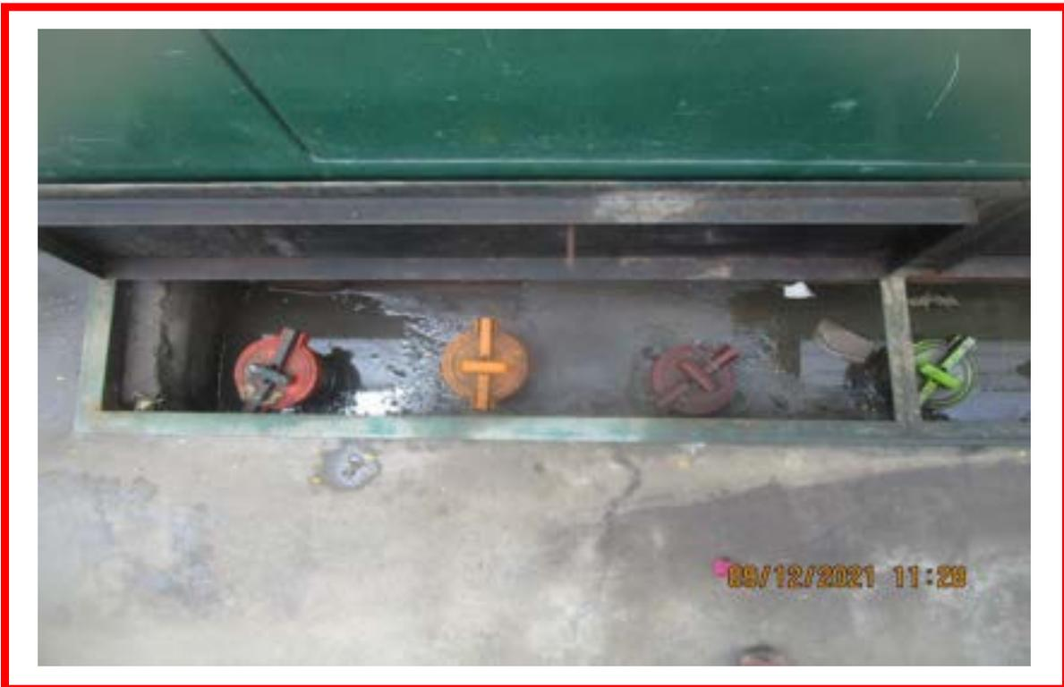
Foto 6. Ubicación de los puntos de descarga de combustibles de Gas 84 (rojo), Gas 97 (amarilla),
