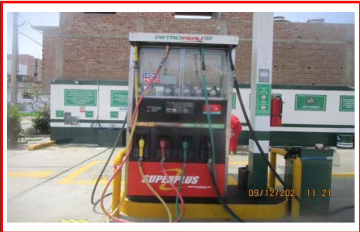
Foto 3. Vista frontal de la Primera Isla con dispensador de 08 mangueras (04 por la parte delantera y 04 por la parte posterior). Gas 97, Gas 84, Gas 90, Diésel.
