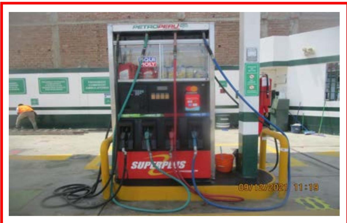
Foto 4. Vista frontal de la Segunda Isla con dispensador de 08 mangueras (04 por la parte delantera y 04 por la parte posterior). Diésel, Gas 90, Gas 84, Gas 95.
