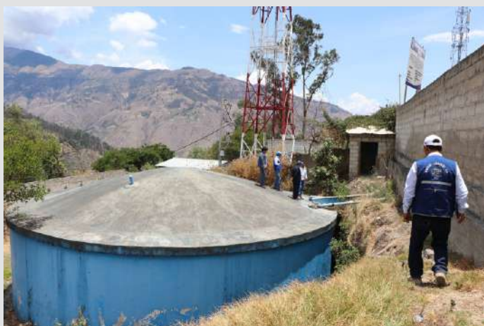
RESERVORIO DE AGUA ANTABAMBA BAJA - TAMBURCO
