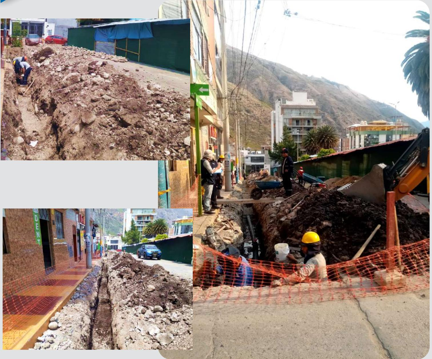
Renovación de red secundaria de agua potable tubería de 110mm de diámetro, se realizó en el Jr. Libertad (a un costado del Parque Centenario).
