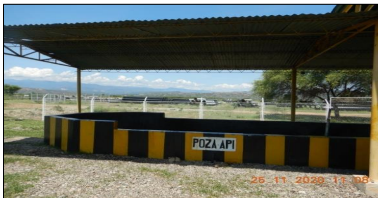
Fotografía N° 11: Punto de muestreo de agua residual industrial, ubicado en la poza a la salida de la Poza API de la Refinería El Milagro.
