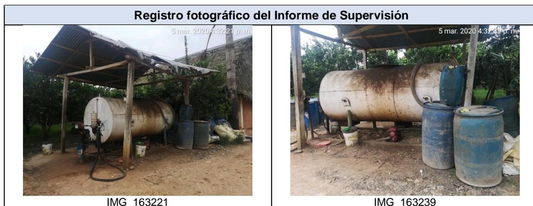
87. Cabe agregar que, de acuerdo con lo señalado en la Ficha de Datos de Seguridad<sup>60</sup>, el diésel debe ser almacenado en áreas ventiladas, alejado de materiales que no sean compatibles y en áreas protegidas del fuego abierto, tal como se detalla a continuación:
