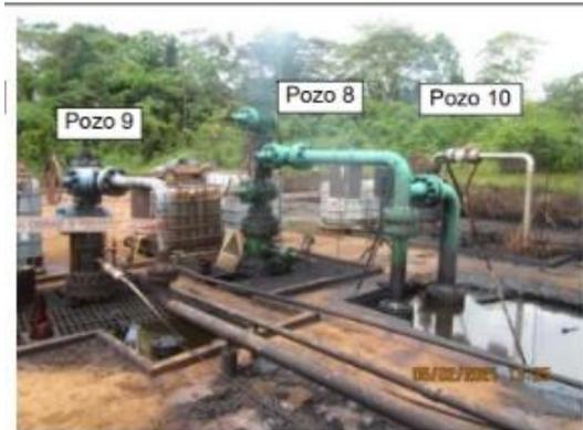
**Fotografía N° 04** Vista panorámica de los pozos productores 9 y 10, además del Pozo de inyector 8 del Yacimiento Forestal registrado con fecha 5 de febrero de 2021. Se evidencia los colores de los cabezales de los tres (3) pozos impregnados de petróleo crudo.
