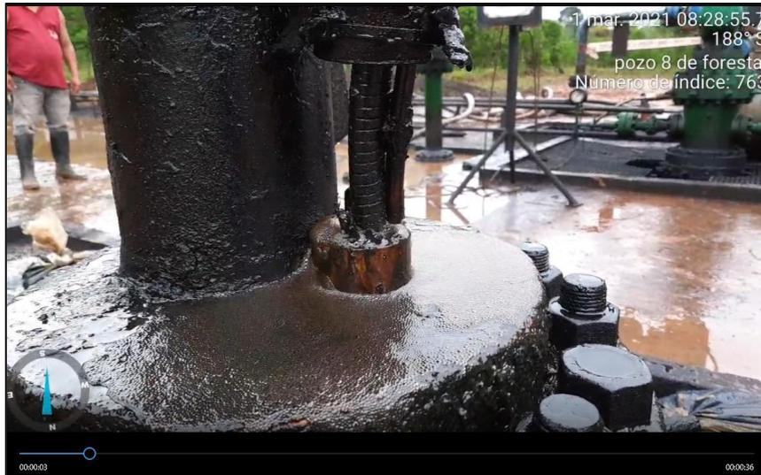
66. Sobre ello, corresponde indicar que, durante la Supervisión Especial 2021-II, se pudo identificar que los cabezales de los pozos 8, 9 y 10 se encontraban impregnados con hidrocarburos
