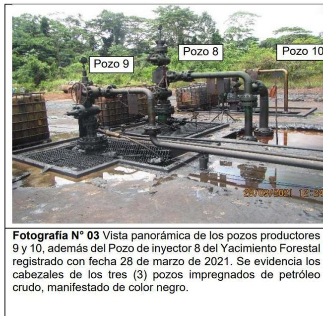
**Fotografía N° 03** Vista panorámica de los pozos productores 9 y 10, además del Pozo de inyector 8 del Yacimiento Forestal registrado con fecha 28 de marzo de 2021. Se evidencia los cabezales de los tres (3) pozos impregnados de petróleo crudo, manifestado de color negro.
