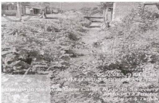
Foto N° 05 Canal colmatado y con falta maleza, requiere descolmatacion y desbroce
