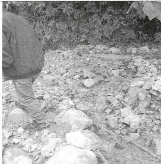
Foto N° 04 Caja del canal totalmente colmatado requiere urgente limpieza
