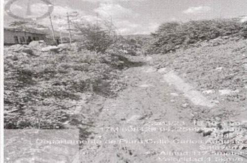
Foto N° 06 Caja del canal totalmente colmatado requiere urgente limpieza
