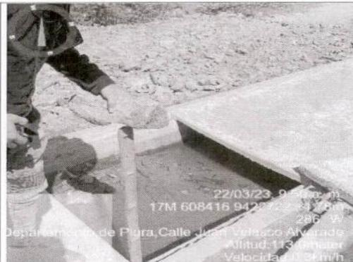
Foto N° 02 En la imagen se aprecia que la caja del canal se encuentra totalmente colmatada de sedimento
