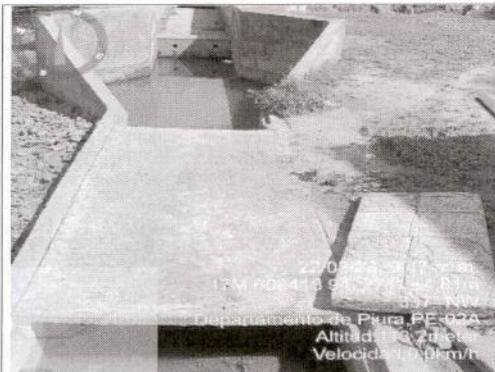
Foto N° 01 Se aprecia la boca toma e inicio del canal Chanchape Colmatado
