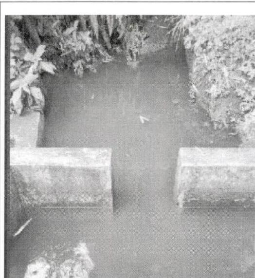
Foto N° 02 Se aprecia que el canal Ha perdido su cauce debido a la colmatacion de la zona
