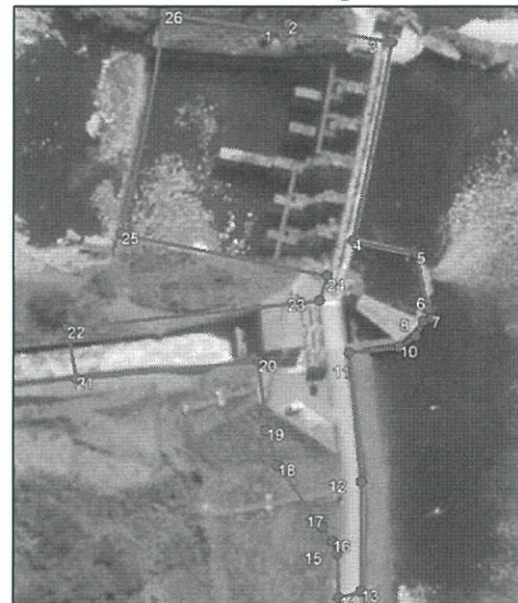
Cámara de carga.
