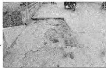
F-2 Malecón Benavides (desorendimiento de losa de concreto)
