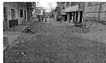
**F-2** Vía dañada en carpeta asfáltica y base granular.
