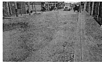
F-3 Av. El Ejercito (pavimento flexible deteriorado).
