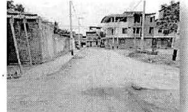
F-2 Vista del pavimento asfáltico deteriorado presentando fisuras v
