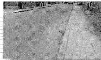
F-2 Av. El Ejercito (pavimento flexible con ahuellamiento).
