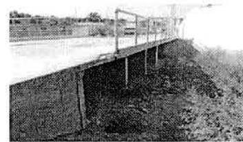
F-2 Concreto armado con desgaste natural por falta de mantenimiento
