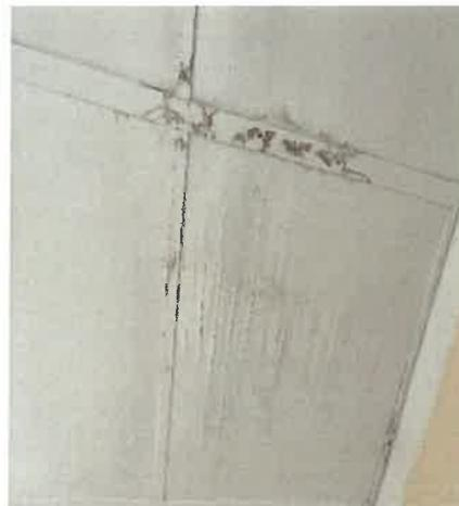
En **bloque I y IV**, de ambientes de materna obstétrica y auditorio, los cielos rasos deteriorados por filtraciones de agua de lluvia.
