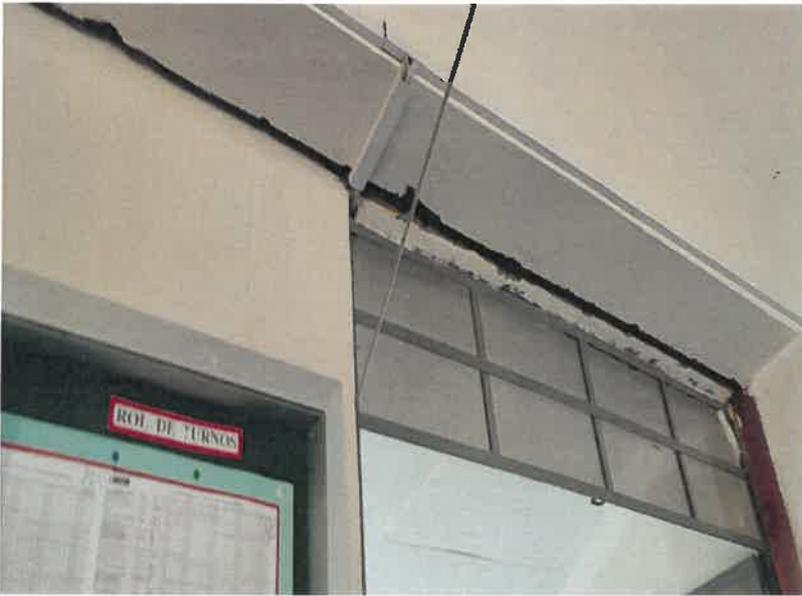
Junta de construcción en el **Bloque I**, sin junta de jebe micro poroso, cuyas aristas de la viga dintel se están desprendiendo.
