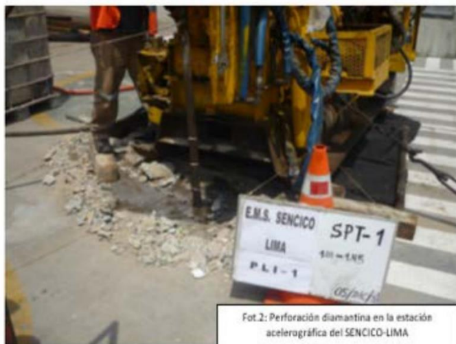
Foto 2: Perforación diamantina en la estación acelerográfica del SENCICO - LIMA.
