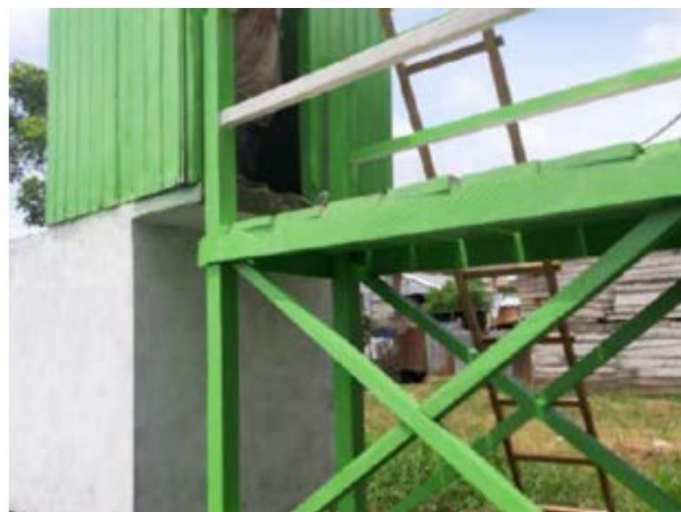
Foto 1: Núcleo sanitario luego del mantenimiento. San Pablo de la Luz, Maynas, Loreto.
