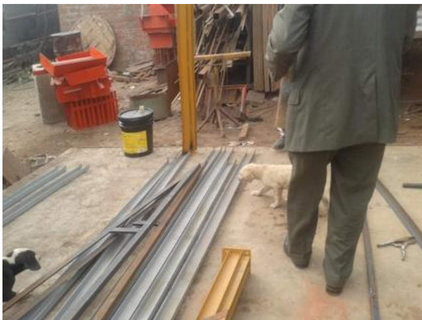
Preparación de tijerales de techo, rieles y columnas
