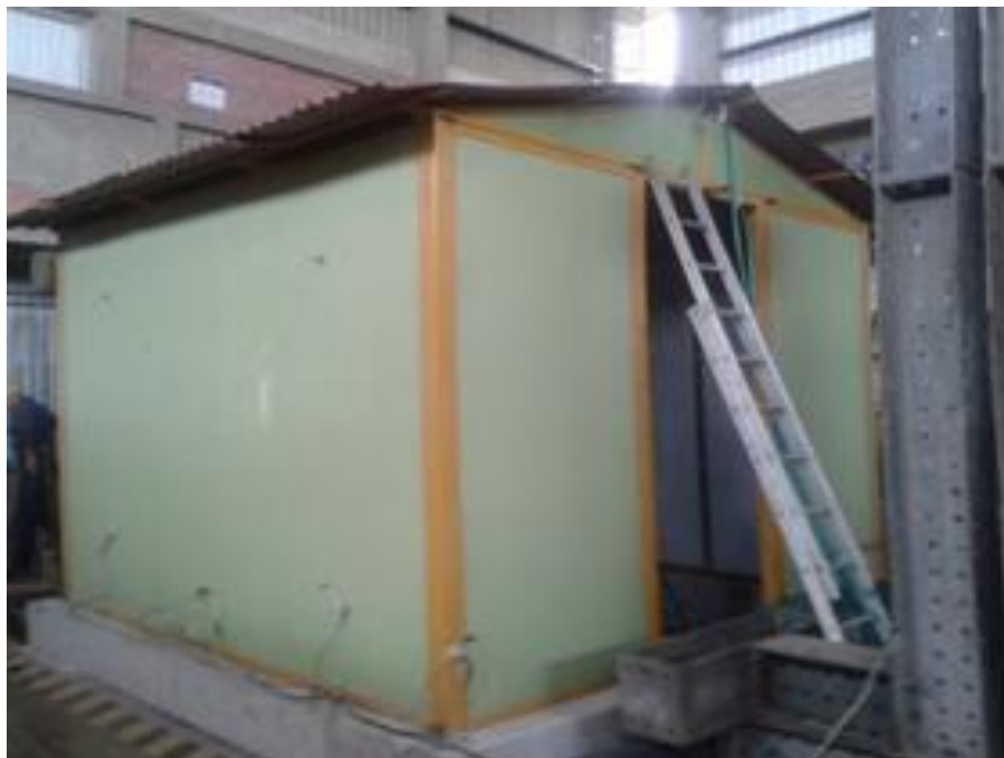
Inspección después de realizada la vibración forzada con aceleraciones en aumento, desde 0,30g a 1,40 g.
