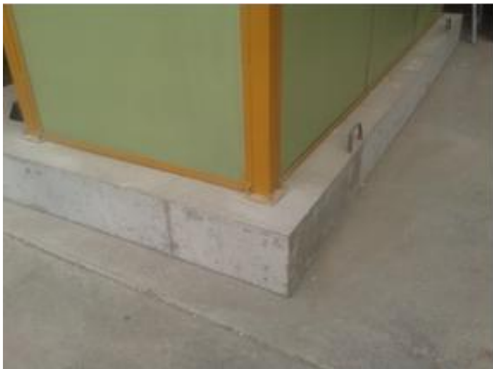
Módulo antes de ser trasladado a la mesa vibradora para ser ensayado
