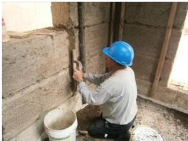
Figura 6.10. Resane de fisuras por contracción.
