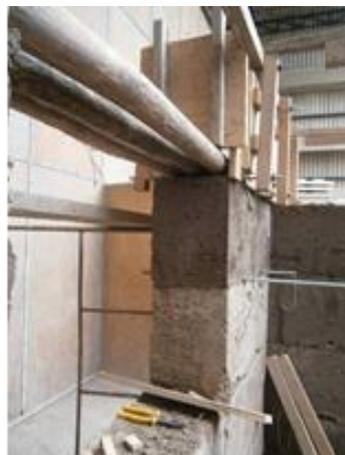
Figura 6.6. Dintel de una de las ventanas del módulo.
