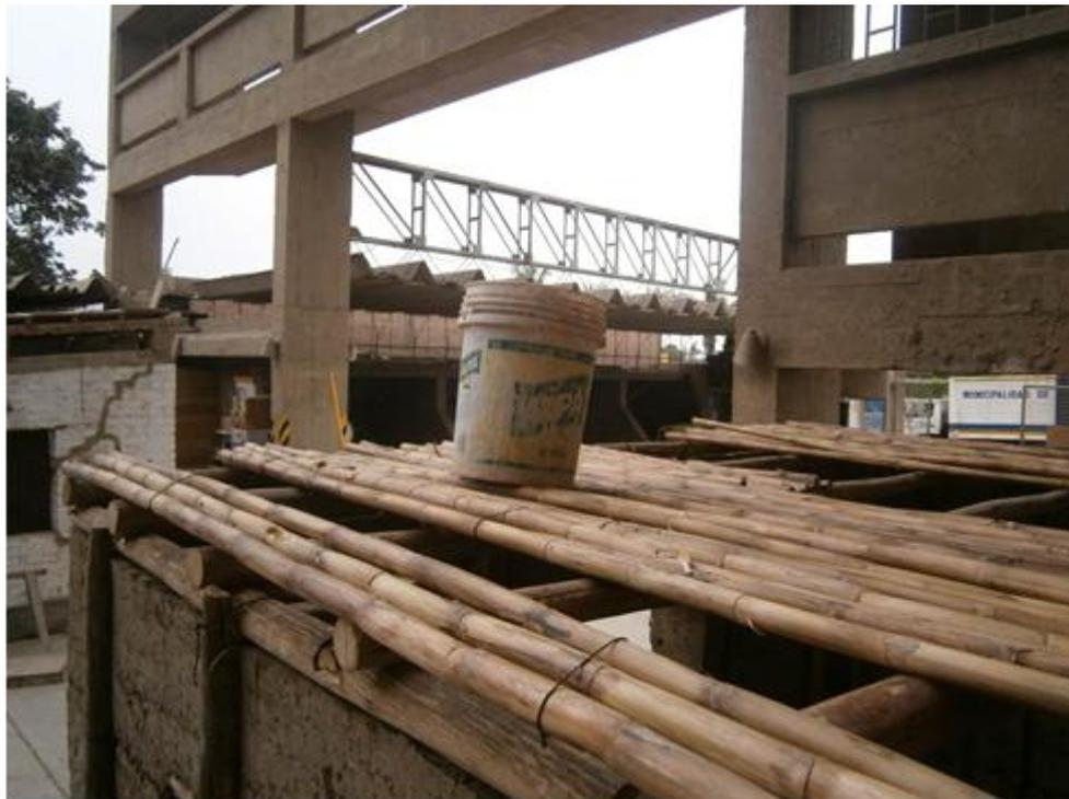
Figura 2.12. Colocación del techo de cañas.
