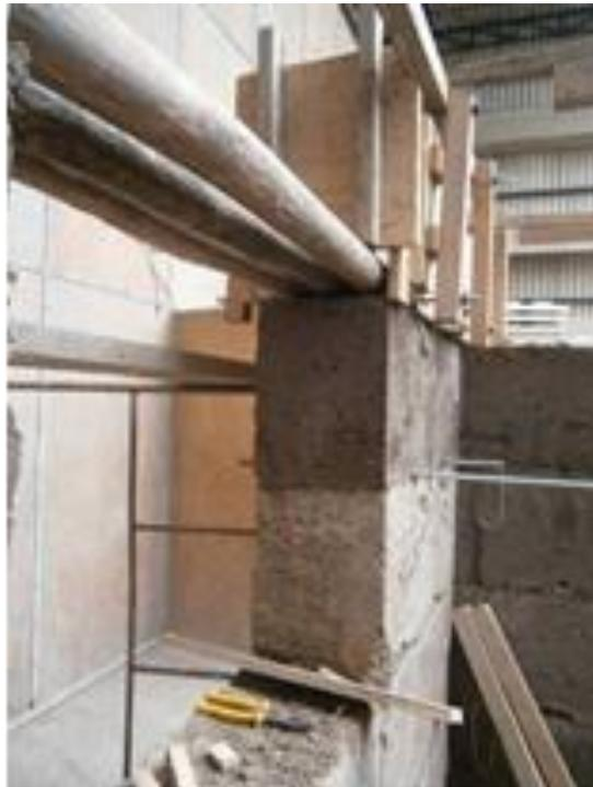
Fig. 5.14. Dintel de una de las ventanas del módulo.
