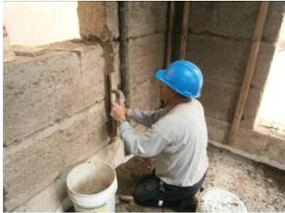
Figura 6.10. Resane de fisuras por contracción.
