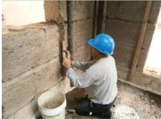
Figura 5.18. Resane de fisuras por contracción.
