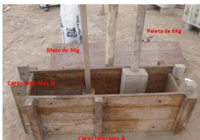
Caras laterales del encofrado y los pisones que se usarán para el moldeo.
