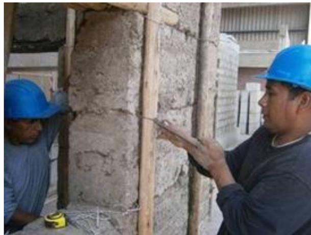
Figura 6.8. Atortolado de los sujetadores de alambre.
