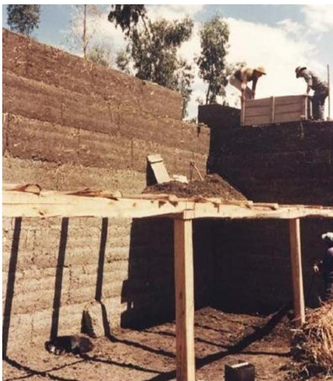
Figura 12. Construcción de un muro de tapial.
