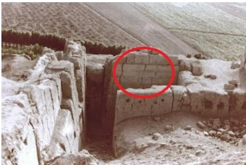
Figura 6. Muros de tapial de La Centinela donde se aprecia el deterioro de estos.
