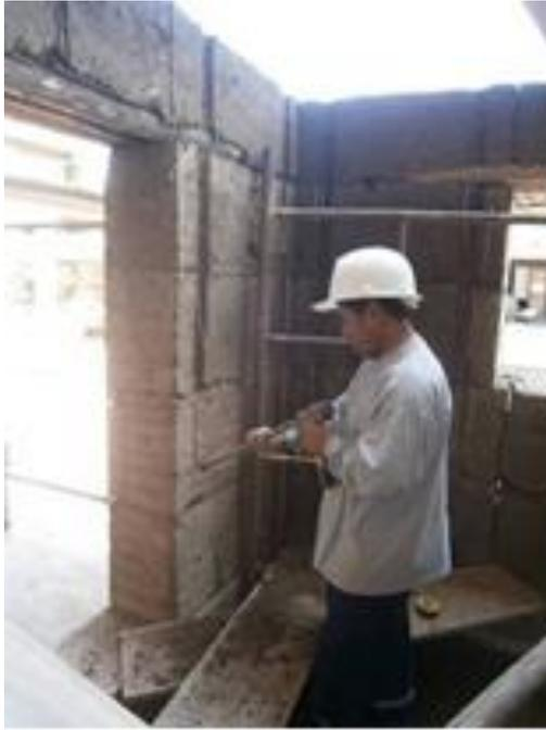
Fig. 5.15. Elaboración de rebajes de máximo 2 cm en los muros del módulo.
