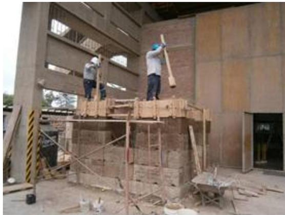
Figura 6.5. Construcción de la quinta hilada del módulo.
