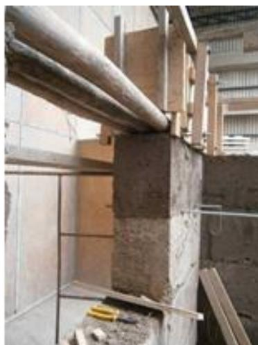
Figura 5.14. Dintel de una de las ventanas del módulo.
