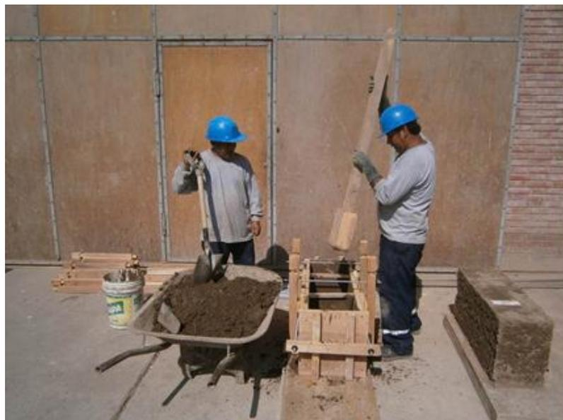
Figuras 2.5 y 2.6. Compactando el suelo colocado dentro del molde.
