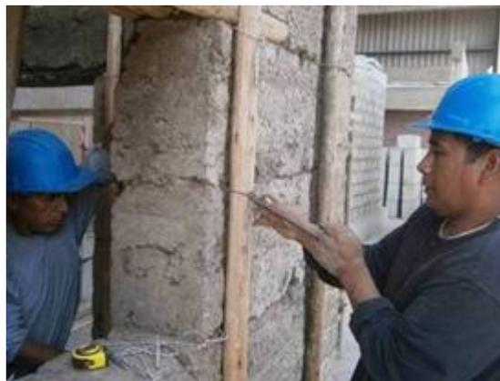
Figura 5.16. Atortolado de los sujetadores de alambre.
