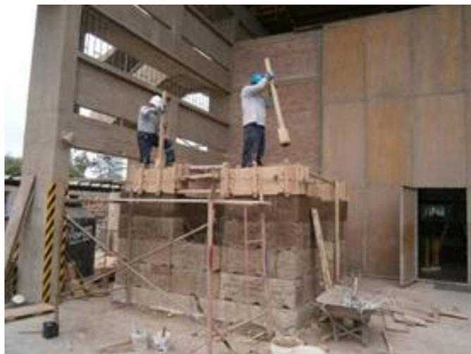
Figura 5.13. Construcción de la quinta hilada del módulo.
