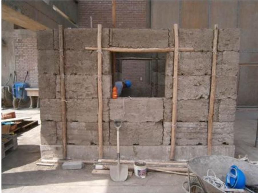
Figura 2.9. Distribución del refuerzo exterior.
