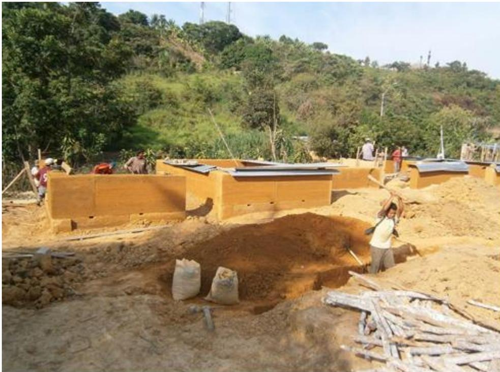
Figura 2.1. Extracción de la tierra adyacente al lugar de construcción de muros.
