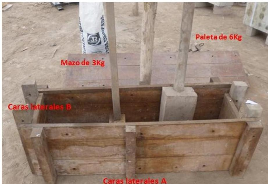
Figura 21. Caras laterales del encofrado y los pisones que se usarán para el moldeo.
