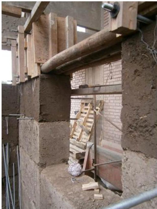
Figura 2.8. Colocación de dintel.
