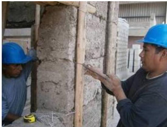
Figura 6.8. Atortolado de los sujetadores de alambre.
