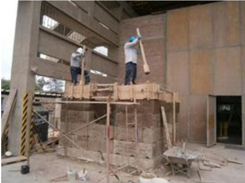
Fig 5.13. Construcción de la quinta hilada del módulo.
