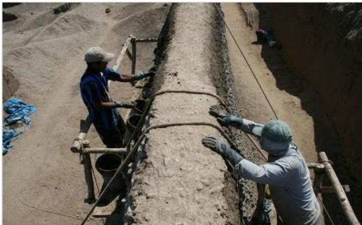
Figura 5. Reparación de las murallas de tapial de Chan Chan. (Llegan a tener 10 metros de alto)
