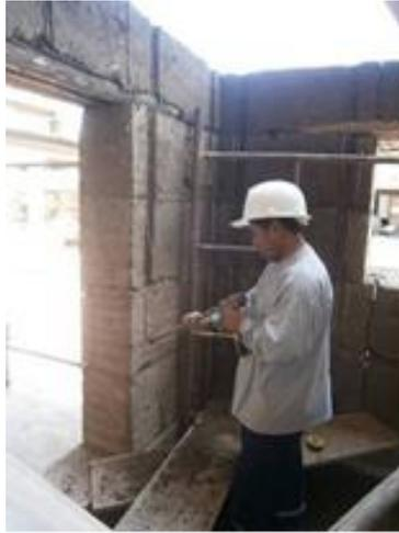
Figura 6.7. Elaboración de rebajes de máximo 2cm en los muros del módulo.
