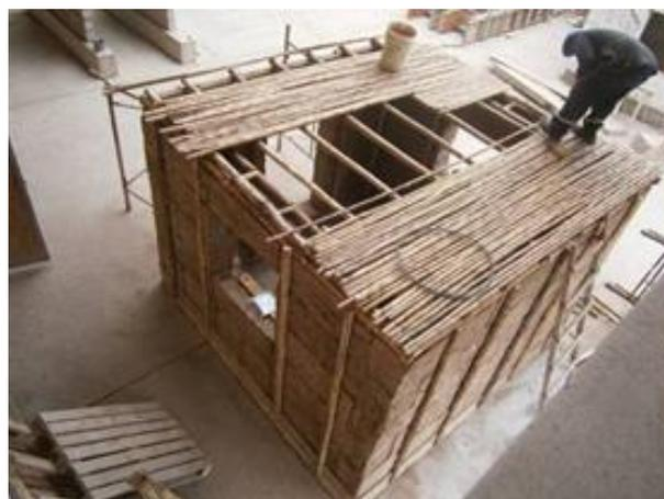
Figura 6.9. Vista del armado del techo.
