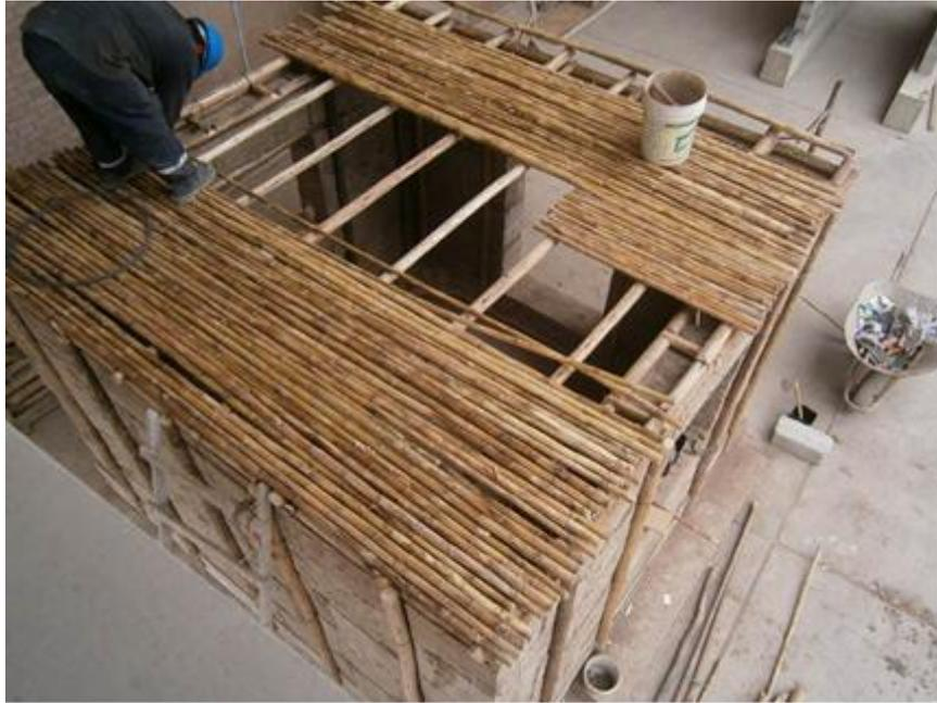
Figura 2.13. Colocación del techo de cañas.
