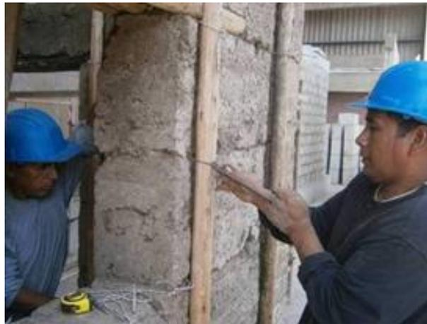
Fig. 5.16. Atortolado de los sujetadores de alambre.
