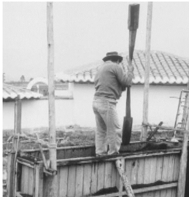
Figura 30: Mazo o pisón usado con dos cabezas. Fuente: Muros de tapial y adobe Minke 2001.
