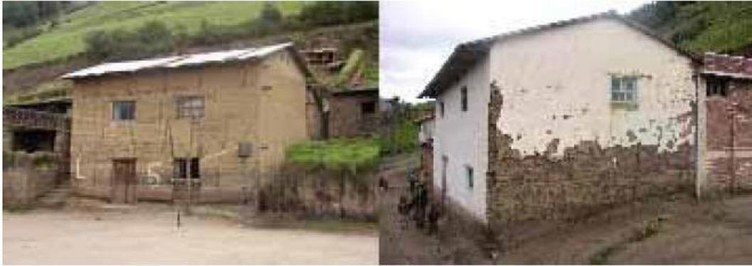
Figura 3. Viviendas construidas con tierra cruda no colapsaron.
