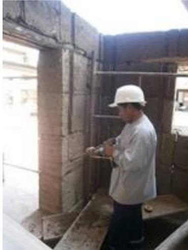
Figura 5.15. Elaboración de rebajes de máximo 2cm en los muros del módulo.
