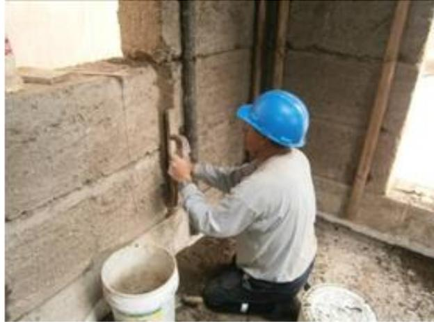
Fig. 5.18. Resane de fisuras por contracción.
