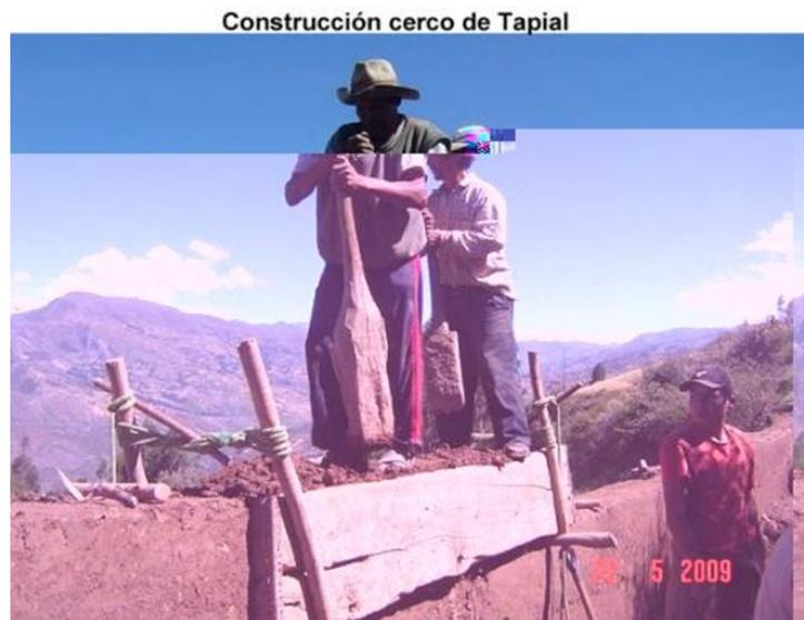
Figura 24. Moldeo y encofrado de tapial en Ancash.
