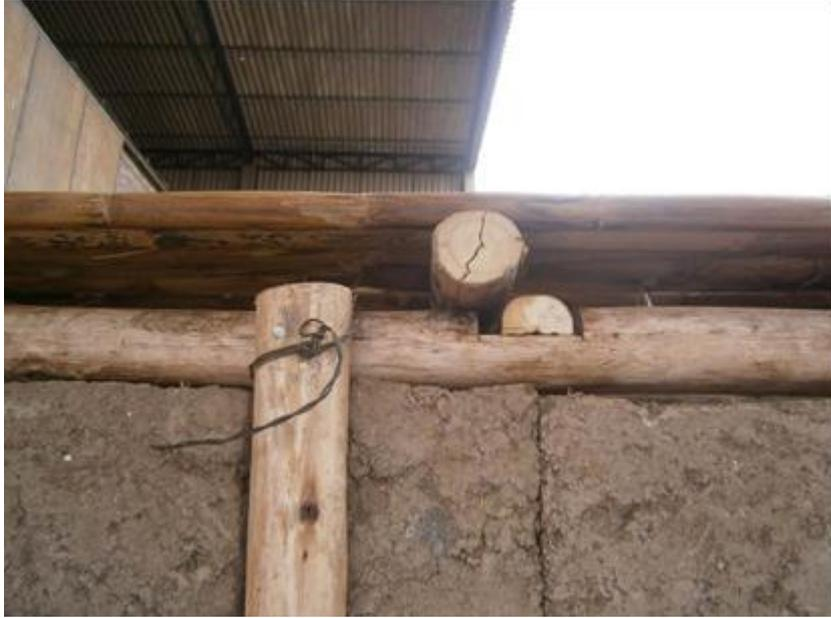
Figura 2.14. Detalle de unión entre refuerzo vertical y solera.
