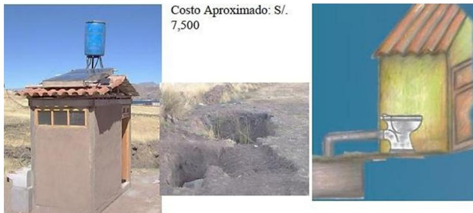
Este baño cuenta con una terma solar para ducha y un biodigestor para el tratamiento de aguas expulsadas por el inodoro, que no contamina el subsuelo donde se almacenan los residuos.
