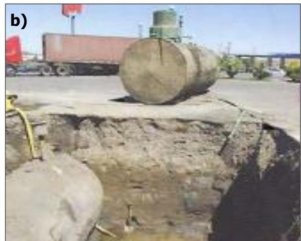
**F-3.06 a y b.** Flotación de cajas de desagüe y tanque de combustible por licuación de suelos.
