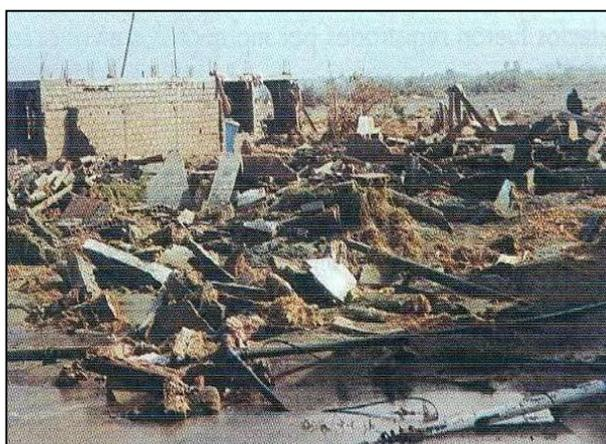
**F-1.03.** Daños causados en viviendas con bloques de concreto en el balneario al sur de Camaná, en 2001-06-03.
