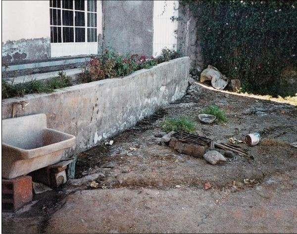
**F-3.14.** Hundimiento de suelo y grieta en suelo causado por licuación de suelo, por tener suelo granular fino y la napa freática a muy poca profundidad.
