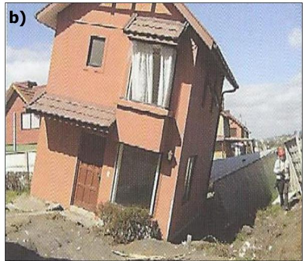
F-3.03 a y b. Inclinación de edificios por asentamiento diferencial, causado por licuación de suelos.
