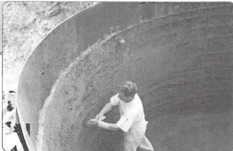
Colocación del mortero de cemento en la parte superior del tanque.
