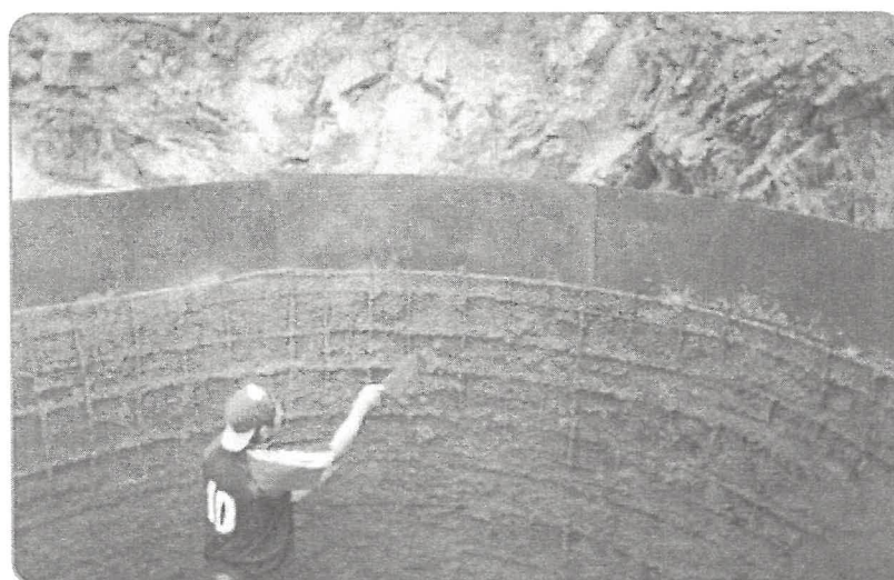
Pañeteo de la estructura metálica desde el interior del tanque, e=4\text{cm} .
