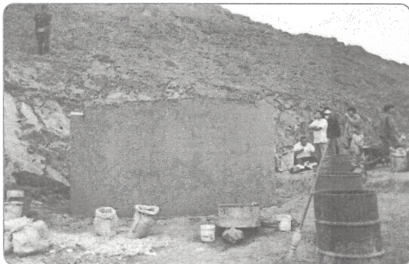
Entre las fases finales de la construcción es de suma importancia el tarrajeo de mortero de cemento en el interior y exterior, colocado con el fin de conformar una capa impermeable.
