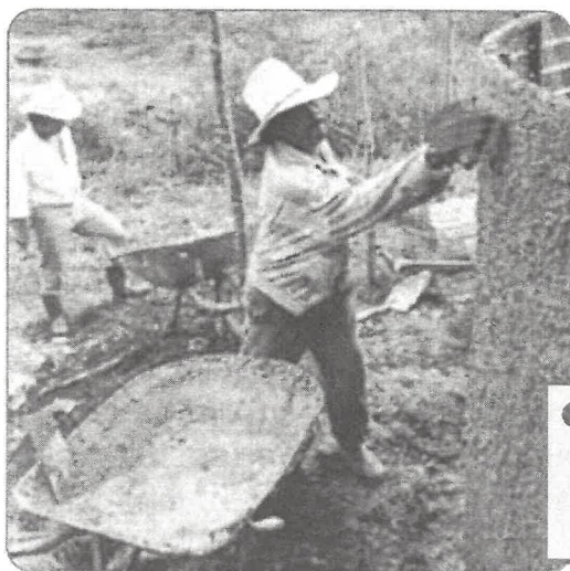
Aplicación de segunda capa de mortero en pared exterior del tanque.
