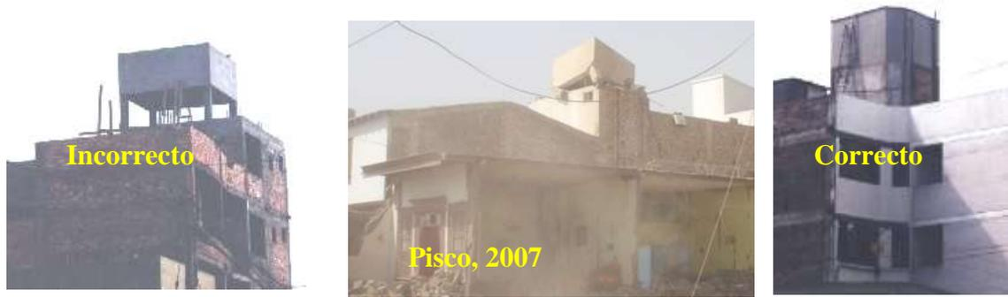
Fig.55. Tanques de agua y solución planteada para evitar su colapso ante los sismos.
