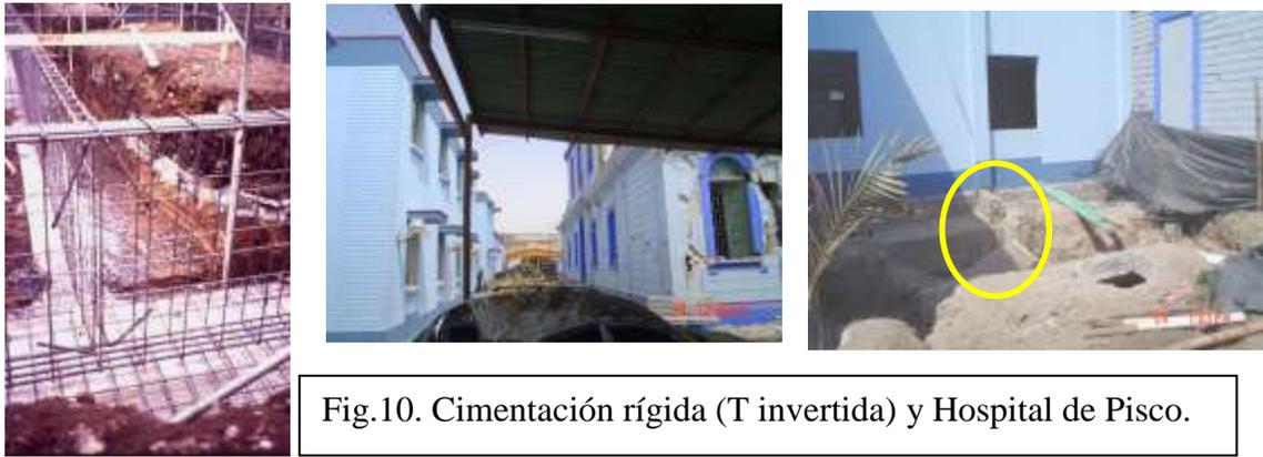
Fig.10. Cimentación rígida (T invertida) y Hospital de Pisco.
