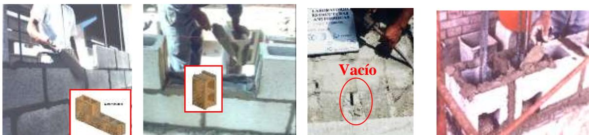
Fig. 19. Cintas de mortero tradicional y junta llena (derecha).
