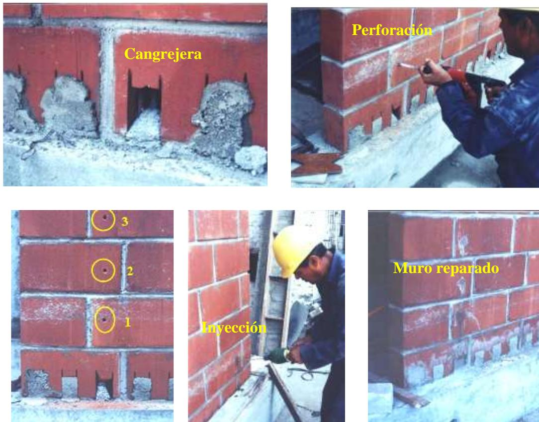
Fig.37. Reparación de cangrejera con inyección de lechada.
