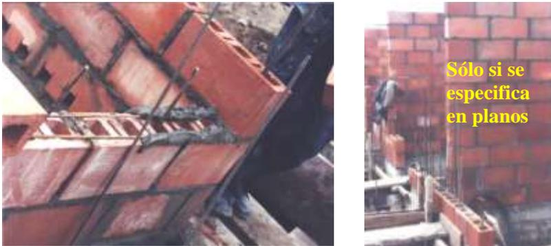
Una de las zonas más críticas de la albañilería armada se presenta en los talones de los bordes libres (sin paredes transversales o con paredes transversales construidas en 2 etapas). Durante los sismos se generan elevados esfuerzos de compresión por flexión en esos talones, que podrían
