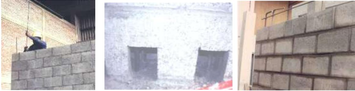
Fig.28. Insertado de barra vertical, traslape y fijación a barra horizontal temporal.
