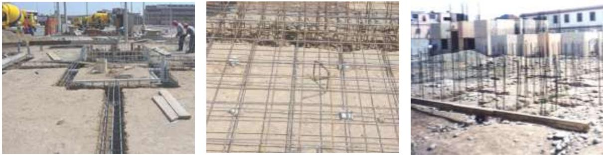
Fig.11.Solado de cimentación y nervaduras donde existen muros.
