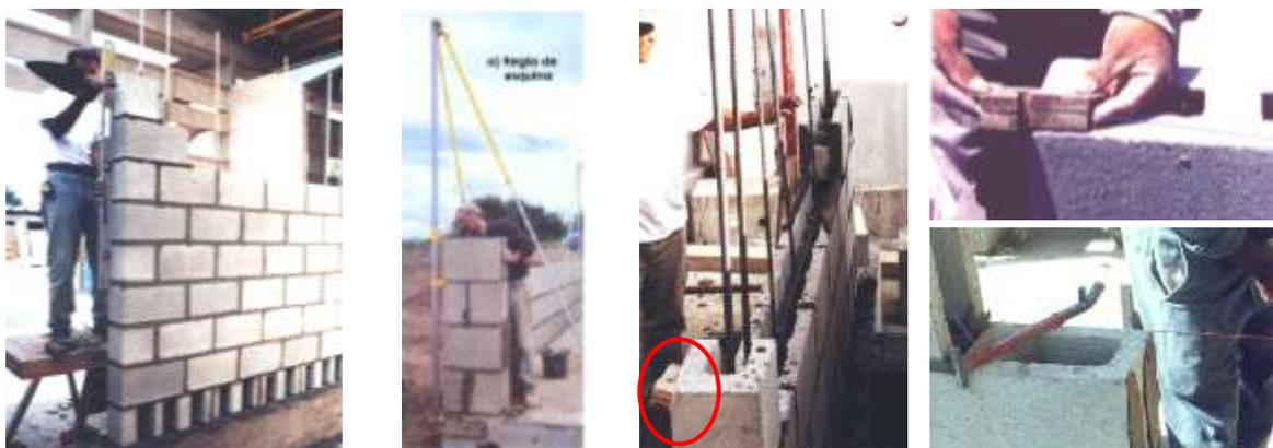
Fig.21. Asentado de bloques maestros y dispositivos para fijar el cordel.
