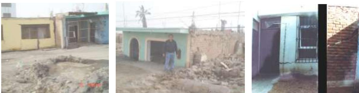
Fig.12. Suelos no aptos para la construcción. Licuación en Tambo de Mora en el sismo de Pisco del 15-08-2007 (izq. y centro), y arcilla expansiva en Talara (der.).
