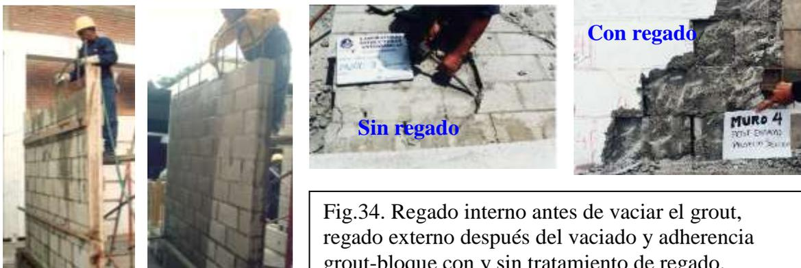
Fig.34. Regado interno antes de vaciar el grout, regado externo después del vaciado y adherencia grout-bloque con y sin tratamiento de regado.
