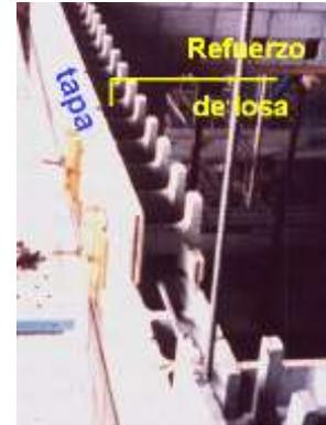
Fig.30. Bloques recortados para ocultar la losa.
