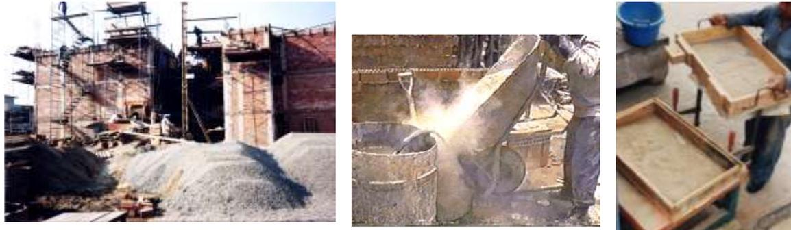
Fig.17. Contaminación de la arena, exceso de polvo y tamizado de la arena.
