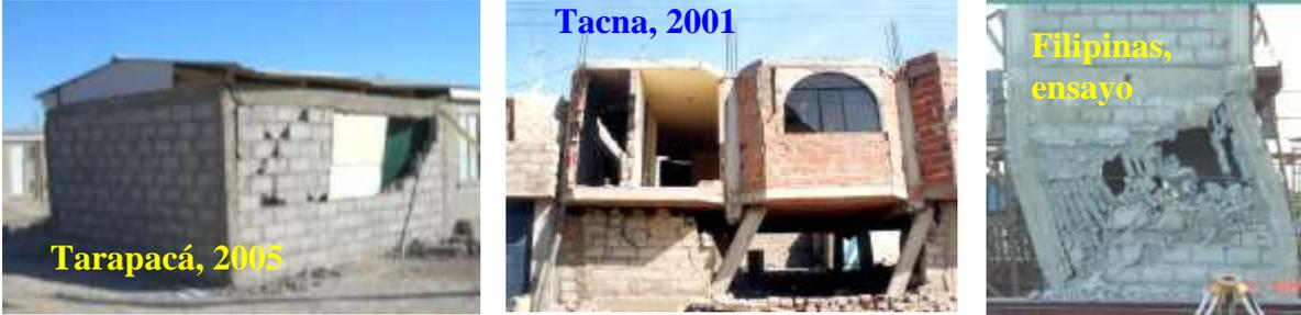
Fig.4. Trituración de bloques vacíos en edificaciones de Albañilería Confinada.
