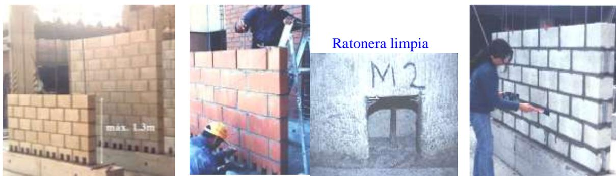
Fig.22. Jornadas de trabajo, limpieza interna de celdas y curado de juntas.
