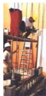
Cuando se usa espigas, al terminar de construir la albañilería y antes de vaciar el grout, se inserta la barra vertical traslapándola con la espiga. Estos traslapes generan congestión de refuerzo en las celdas que podrían provocar cangrejas en el grout. Además, cuando los traslapes tienen la
