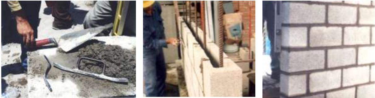
Fig.20. Plancheta, badilejo, bruñador y bruñado de juntas.
