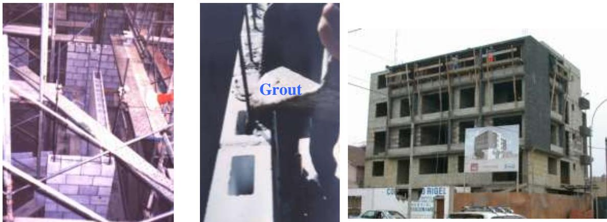
Fig.1. Edificaciones de Albañilería Armada. Nótese que el grout se vacía después de haberse construido la albañilería.
