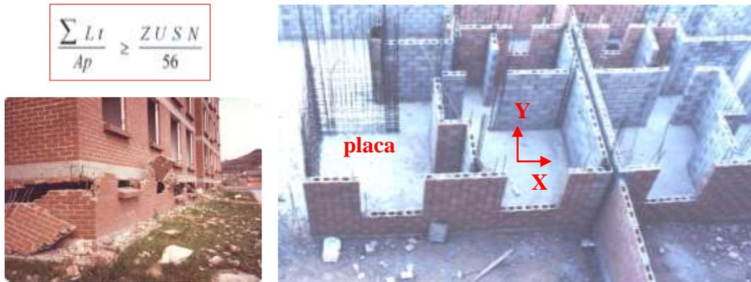
Fig.44. Expresión para determinar la densidad mínima de muros en cada dirección (X, Y) y colapso por falta de densidad de muros.
