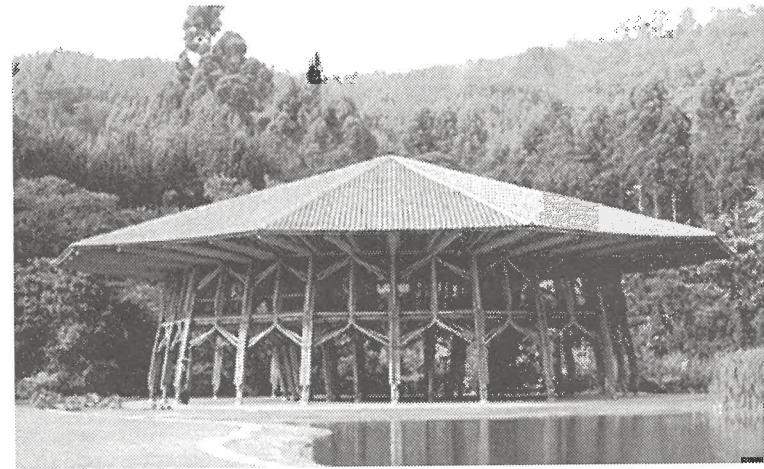
Protección por diseño: Coberturas y dados en la base
