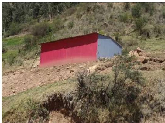
Vivienda afectada por el talud proyectado
