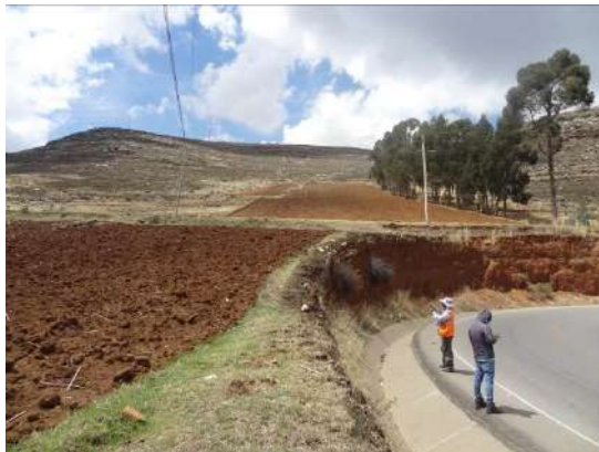
Afectación de terrenos de cultivo aledaños a la vía
