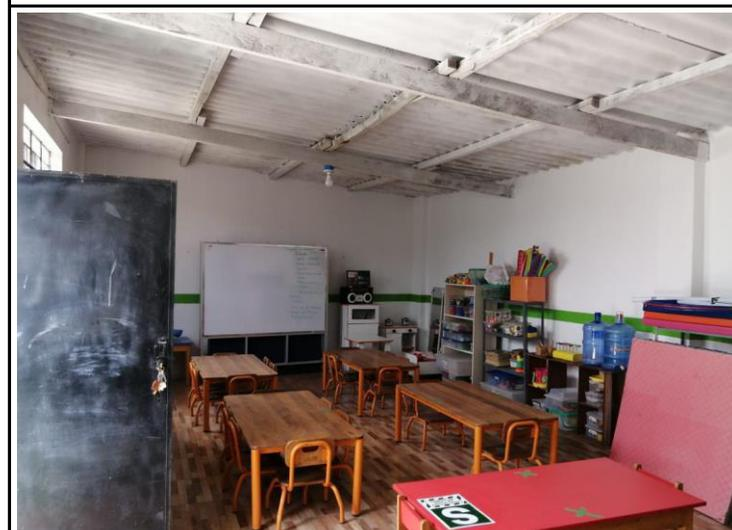
VISTA INTERIOR DE AULA DE MATERIAL NOBLE, TECHO CON ESTRUCTURA DE MADERA Y COBERTURA DE FIBROCEMENTO
