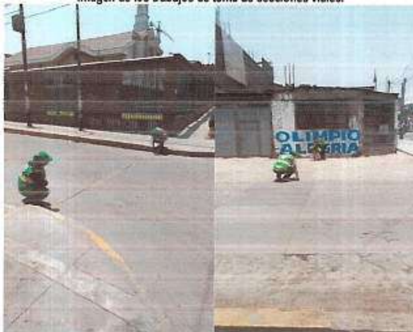
Imagen de los trabajos de toma de secciones viales.
