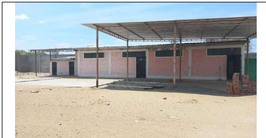
FOTO N° 02: Vista de las 02 Aulas, SS.HH., losa techada.
