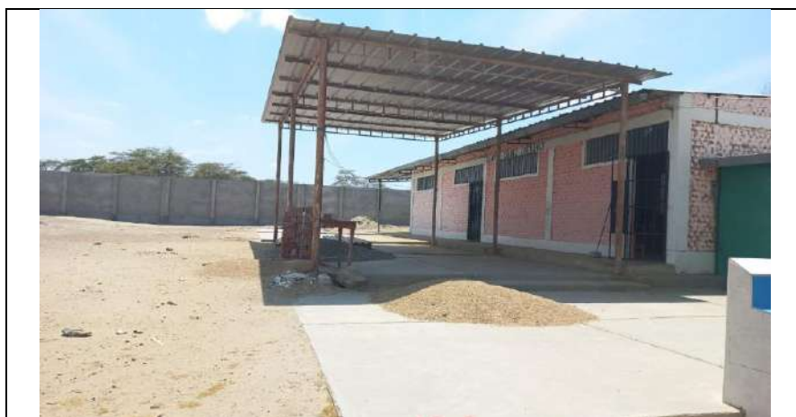
FOTO N° 03: Vista de las 02 aulas, losa techada y lavadero construido en el 2021.
