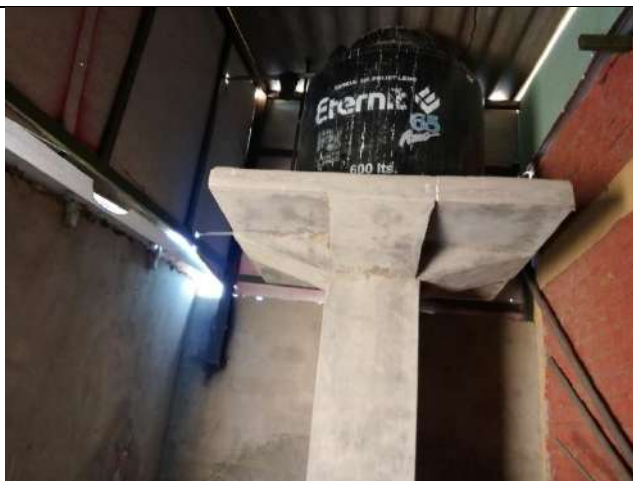
FOTO N° 07: Vista del apoyo del tanque prefabricado.
