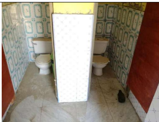
FOTO N° 06: Vista del SS.HH.
