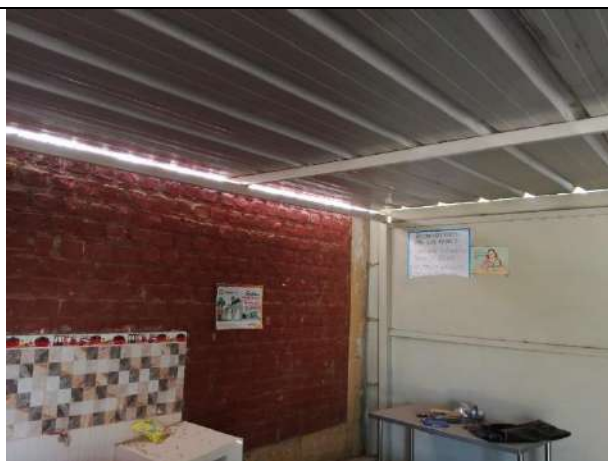
FOTO N° 08: Vista del ambiente de cocina, se aprecia los tabiques de triplay y el techo liviano.
