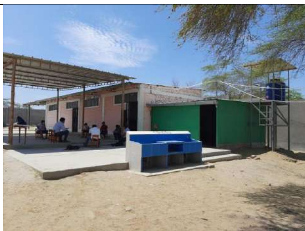
FOTO N° 11: En esta vista se aprecia el lavadero, cocina y las aulas al fondo, se puede notar el patio techado.
