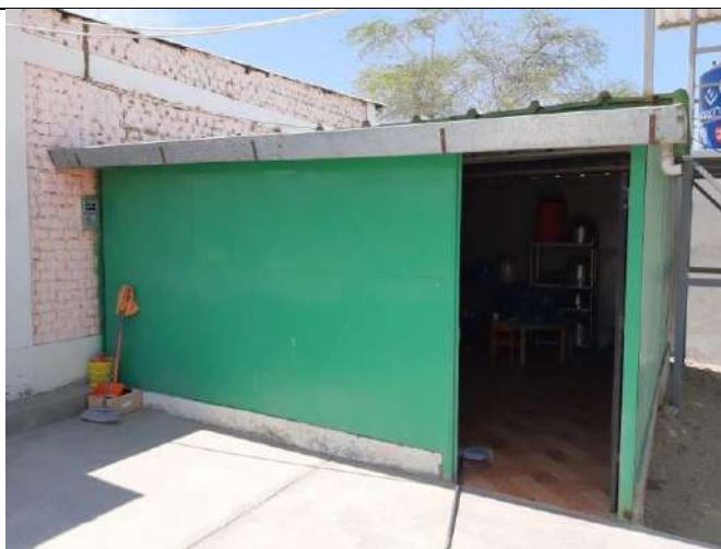
FOTO N° 09: Vista del ambiente de cocina, se aprecia los tabiques de triplay y el techo liviano.
