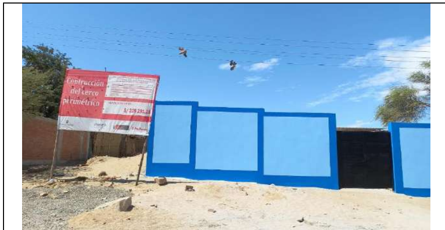
FOTO N° 01: Vista del cerco perimétrico construido por Pronied en el año 2021.
