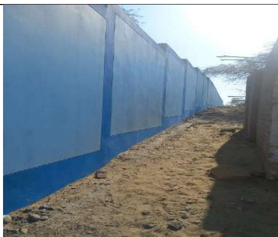
FOTO N° 12: Vista del otro lado cerco perimétrico construido por Pronied en el año 2021.
