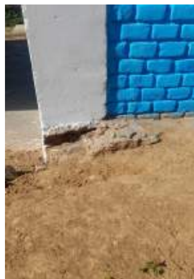
Fotografía N°3: Se muestra el interior de la cocina donde se verifica la filtración en las paredes y el exterior de las columnas en mal estado de la cocina existente.
