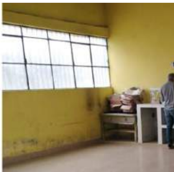
Fotografía N°3: Se muestra el interior de la cocina donde se verifica la filtración en las paredes y el exterior de las columnas en mal estado de la cocina existente.
