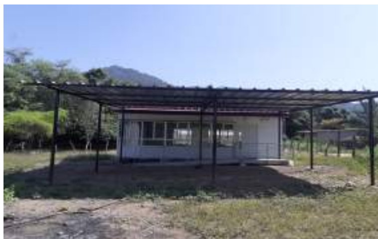
Fotografía N°04: Se verifica el módulo educativo prefabricado en buenas condiciones.
