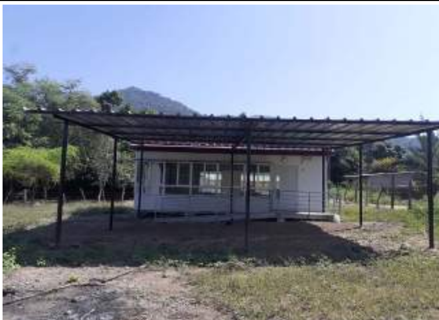
FOTO N° 4: Se verifica el modulo educativo prefabricado en buenas condiciones.
