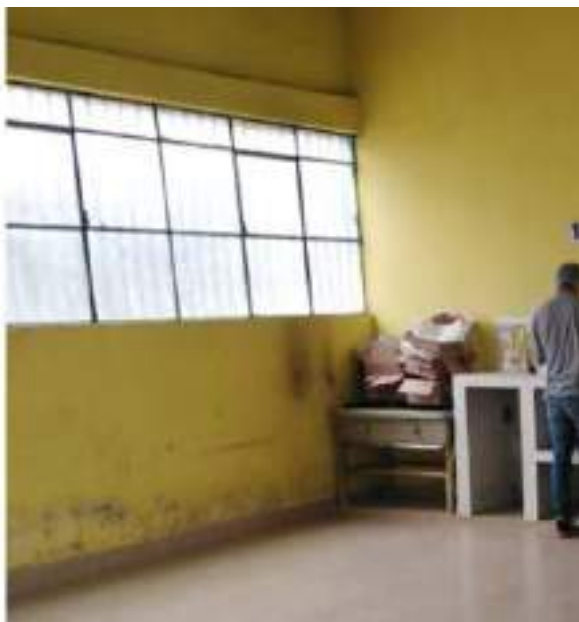
FOTO N° 03: Se muestra el interior de la cocina donde se verifica la filtración en las paredes y el exterior de las columnas en mal estado de la cocina existente. Se muestra el exterior de la cocina.
