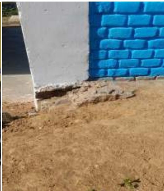
FOTO N° 03: Se muestra el interior de la cocina donde se verifica la filtración en las paredes y el exterior de las columnas en mal estado de la cocina existente. Se muestra el exterior de la cocina.
