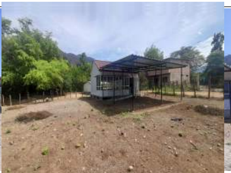
FOTO N° 02: Se muestra el exterior del almacén de material adobe.
