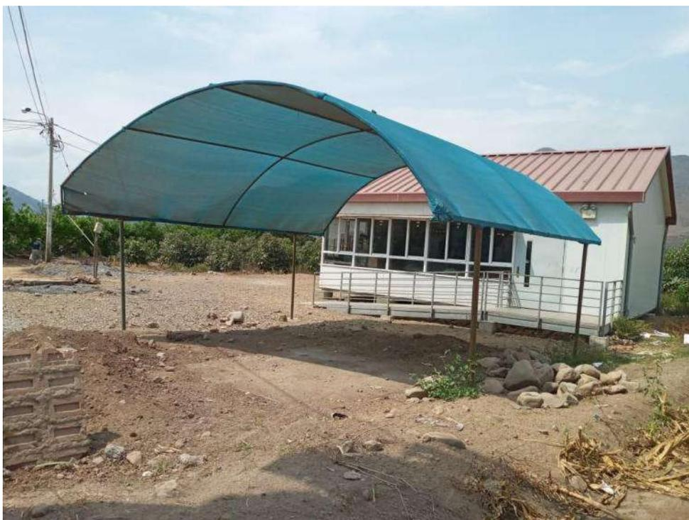
Fotografía N°3: Se visualiza cobertura de lona con estructura metálica deteriorada.
