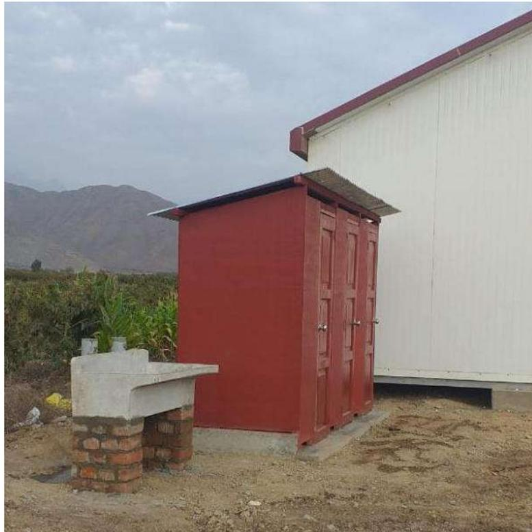
Fotografía N°4: Se observa los SS. HH construido con material precario; cuenta con financiamiento
