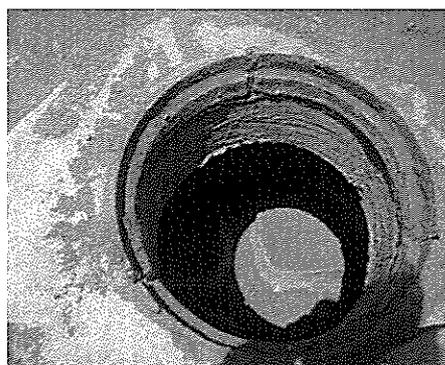
Foto 04. Buzón ubicado frente al local del Gremio de Pescadores observando el fondo con arena, y el acabado deficiente del interior,
