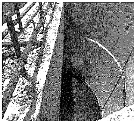
Foto 02. Presencia de agua filtrante en la Cámara de Rejas
