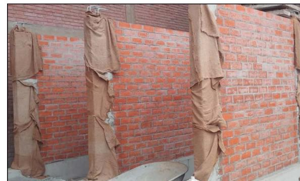
Figura 5: Curado de columnas en muros de ensayo.
