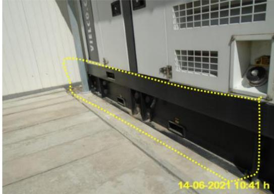
Se observa el área donde se ubica el grupo electrógeno. Esta área no cuenta con un sistema de contención ante derrames o fugas de las sustancias oleosas que contiene dicho equipo.
