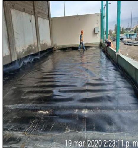
Geomembrana sobre el piso de concreto del “Almacén de Desecho Líquidos”, ubicado al interior de la Subestación Eléctrica Camaná
