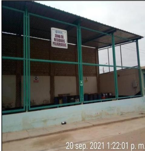
Techo metálico, muro de concreto, con mallas y estructuras metálicas en el “Almacén de Desecho Líquidos”, ubicado al interior de la Subestación Eléctrica Camaná
