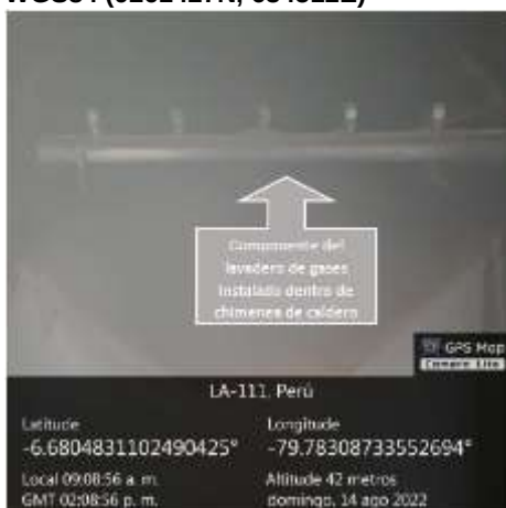
Fotografía N° 7: Componente del lavadero de gases instalado dentro de chimenea de caldero. (14/08/2022) coordenadas UTM WGS84 (9261427N, 634512E)
