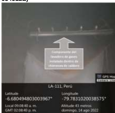
Fotografía N° 7: Componente del lavadero de gases instalado dentro de chimenea de caldero. (14/08/2022) coordenadas UTM WGS84 (9261427N, 634512E)
