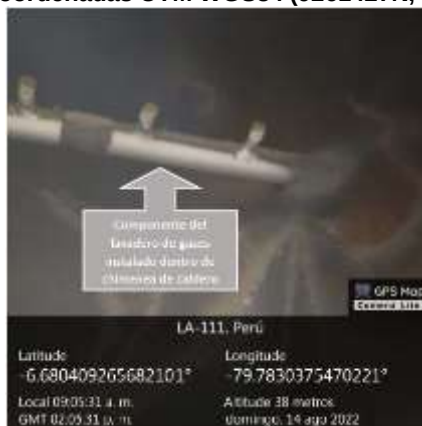
Fotografía N° 7: Componente del lavadero de gases instalado dentro de chimenea de caldero. (14/08/2022) coordenadas UTM WGS84 (9261427N, 634512E)
