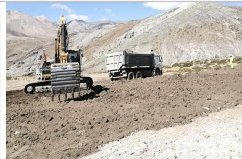
Fotografía 7: Traslado y conformación de material Top Soil en el Relleno Sanitario.
