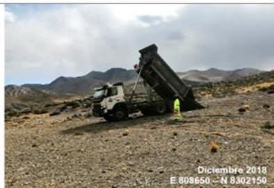
Fotografía 4: Descarga de material Topsoil en la zona de Relleno Sanitario INF-RS-01
