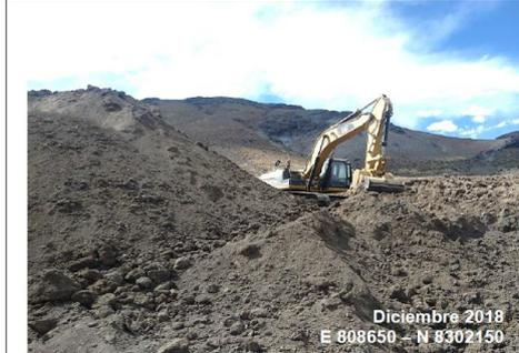
Fotografía 3: Preparación de material Topsoil en la cantera Sihuincha para INF-RS-01
