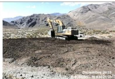
Fotografía 6: Colocado de material drenante en el área del Relleno Sanitario
