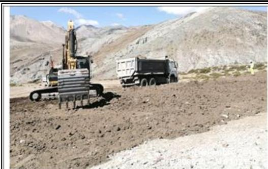
Fotografía 7: Traslado y conformación de material Top Soil en el Relleno Sanitario.
