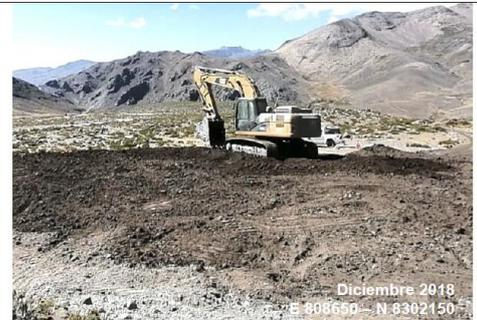
Fotografía 6: Colocado de material drenante en el área del Relleno Sanitario
