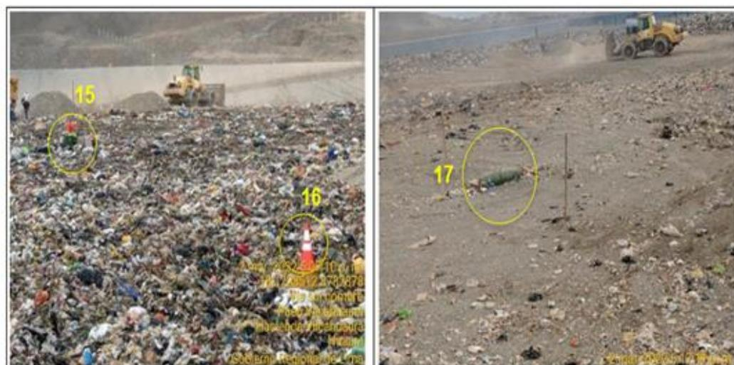
Se observa la implementación de tres (03) chimeneas en la zona 2 de la celda de disposición final ubicada en las coordenadas 18L 228323 E 8782879 N, en las cuales se encuentran casi cubiertas por los residuos sólidos municipales y una de ellas derrumbada
