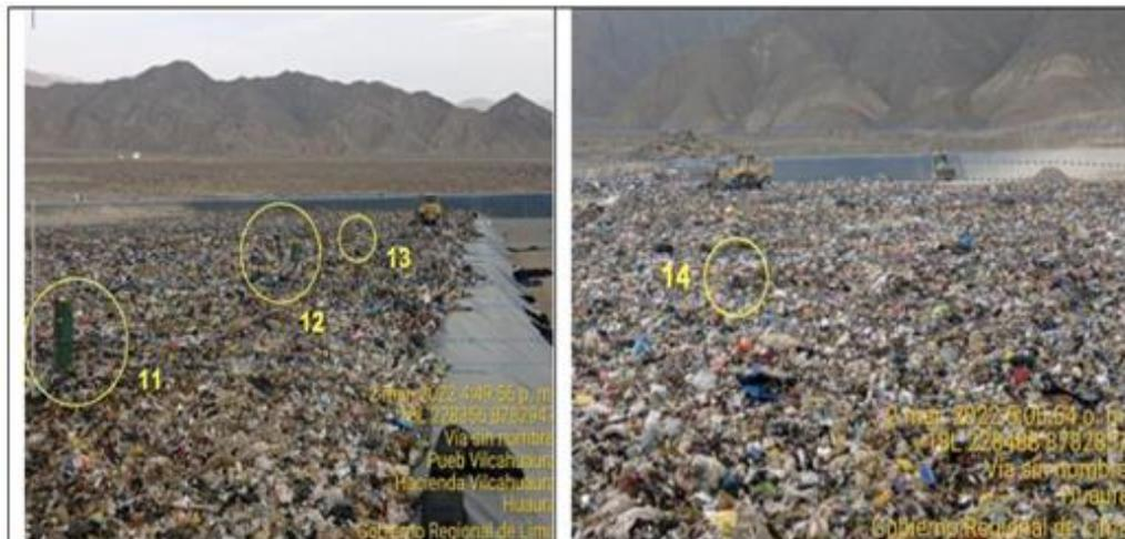
Se observa la implementación de cuatro (04) chimeneas en la zona 2 de la celda de disposición final ubicada en las coordenadas 18L 228323E 8782879N
