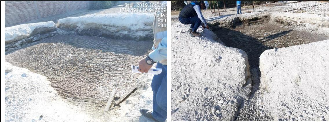
Poza de 50.25 m<sup>3</sup> de capacidad ubicada en la parte posterior del EIP donde se observó espumas y capas de lodos (natas de grasa) que no son tratadas ni retiradas por una EO-RS.
