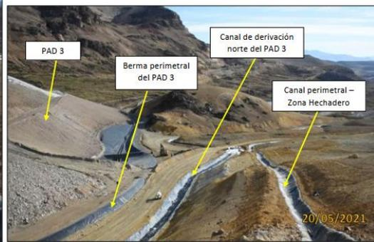
Fotografía 27. A la derecha vista panorámica del canal de conducción de aguas de contacto en la zona echadero, asimismo, a la izquierda se observa el canal de derivación norte del PAD 3.
