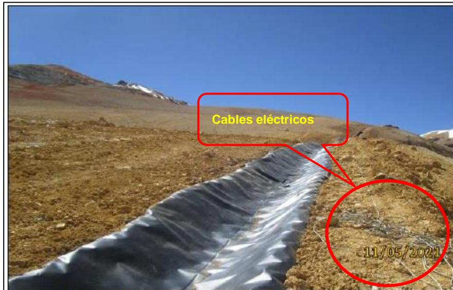
**Fotografía 12.** Vista de la culminación de la impermeabilización del canal de conducción de aguas de contacto, en la cual no se observan flujos de agua.
