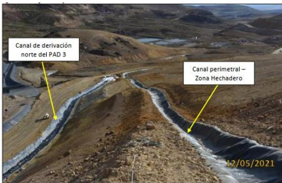
Fotografía 26. Vista de la culminación de la impermeabilización del canal de conducción de aguas de contacto perimetral de la zona echadero en la cual no se observan flujos de agua. En la parte baja se observa el canal de derivación norte del PAD 3.
