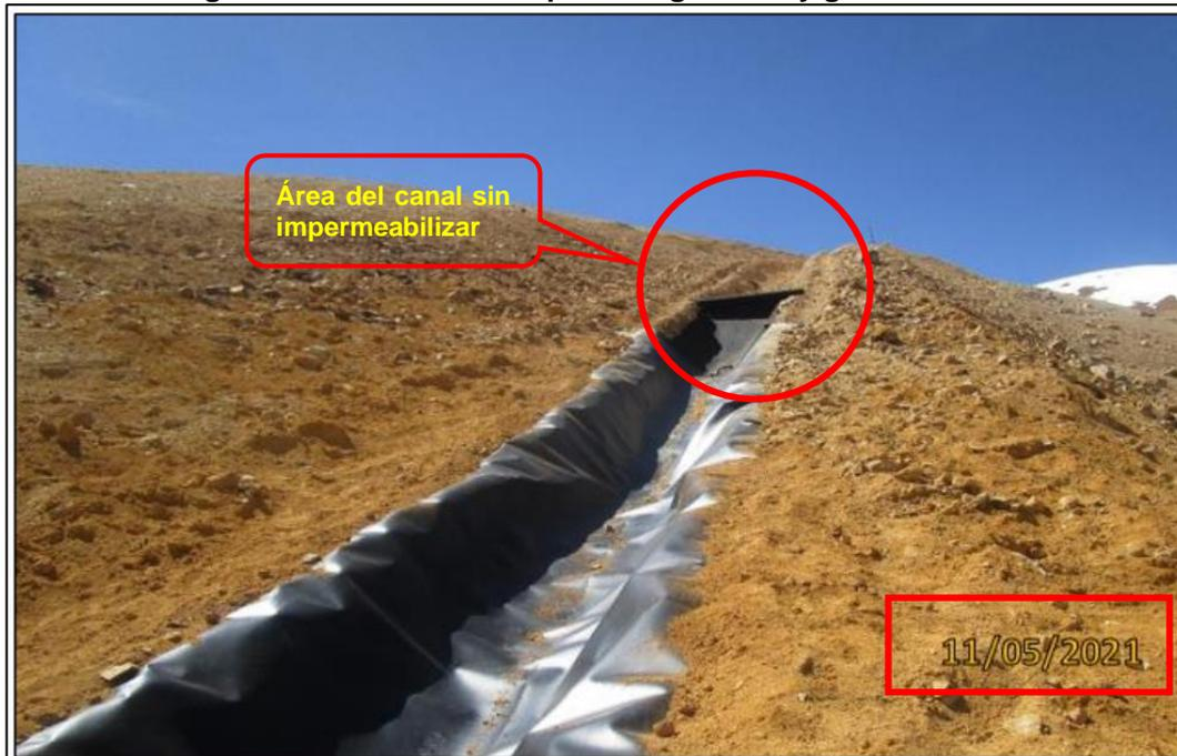
**Fotografía 11.** Vista del tendido de geotextil y geomembrana para la habilitación del canal de conducción de aguas de contacto.
