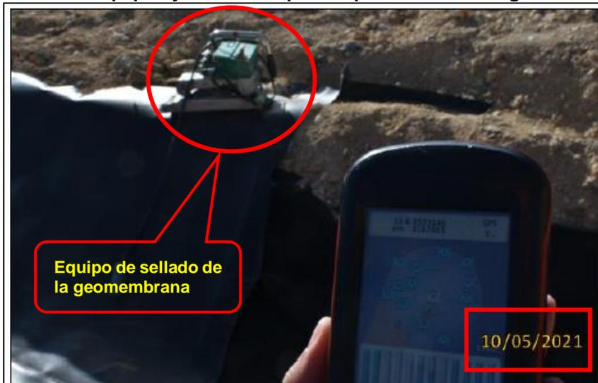
**Fotografía 7.** Vista del tendido de geomembrana para la habilitación del canal de conducción de aguas de contacto. Coordenadas de ubicación UTM WGS 84 N: 8167005, E: 373140. Zona 19K.
