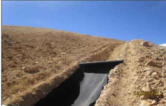
Fotografía 10. Vista del tendido de geotextil para la habilitación del canal de conducción de aguas de contacto.
