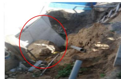
Caída de terreno que afectó al Módulo instalado el 2016.
